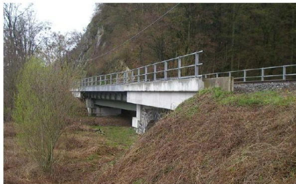
Abb. 8.1: Ansicht des Farrenbachviadukts
