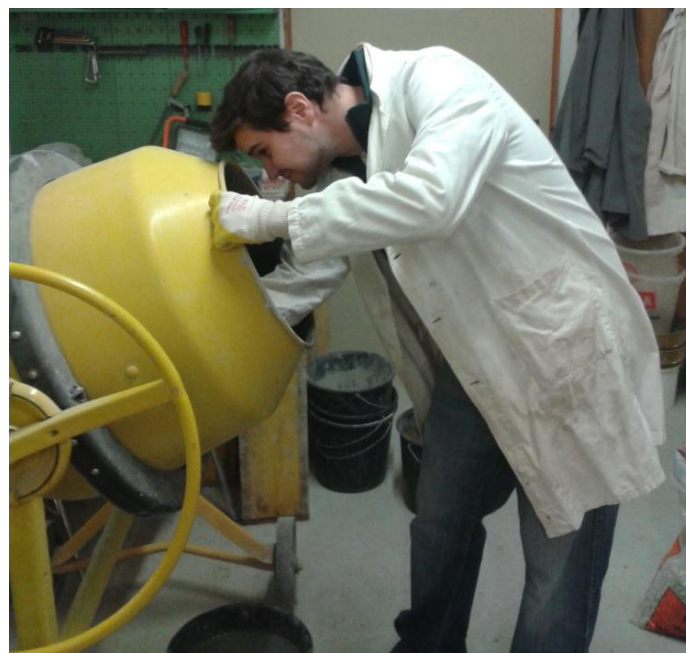
Abbildung 7.32: Betonmischen mittels einer Kipptrummelmischmaschine
