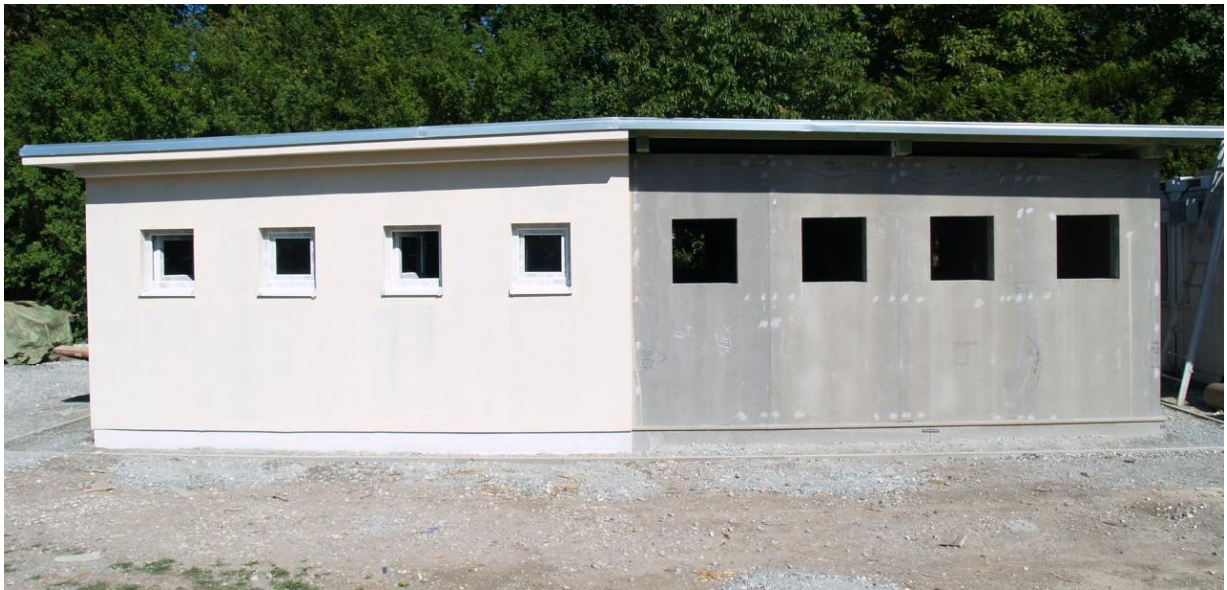
Abbildung 6.6: Testhaus Ansicht: links in gedämmter Ausführung und rechts ungedämmt
