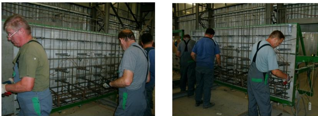
Abbildung 3.2: Montage der Elemente im Werk
