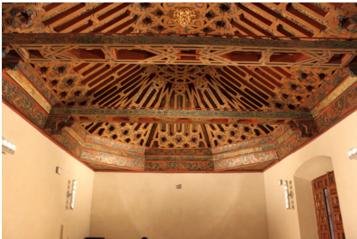
Abbildung 15: Decke, Saal der 24 Ritter, Granada.
