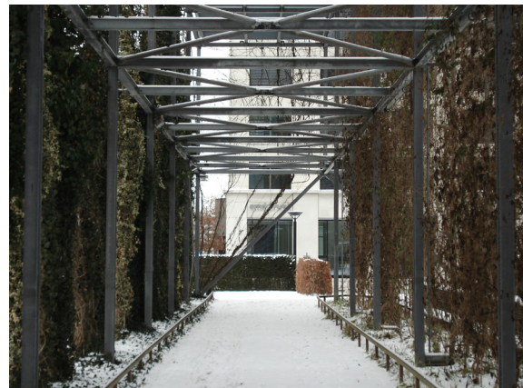
Abb. 7.9 : Doppelwand beim nördlichen Abschluss (2010)
