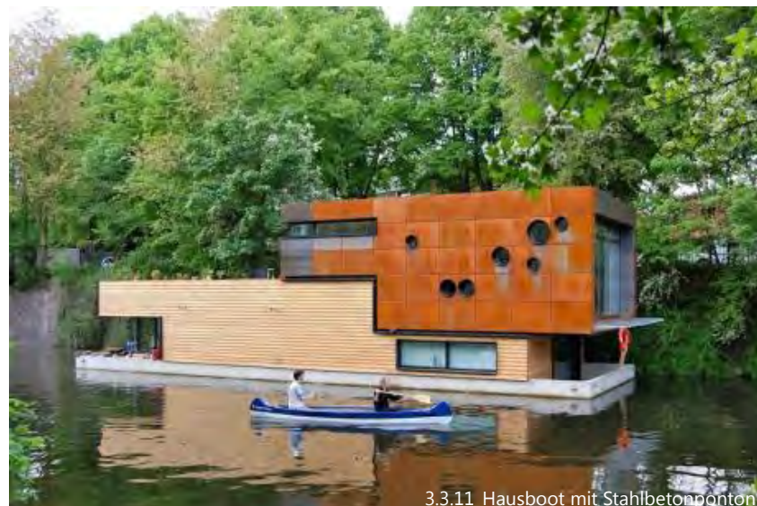
3.3.11_Hausboot mit Stahlbetonponton
