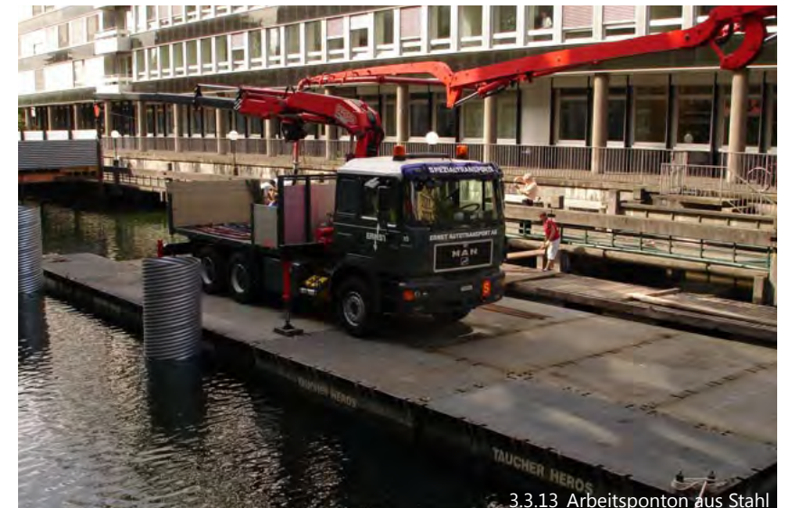
3.3.13_Arbeitsponton aus Stahl
