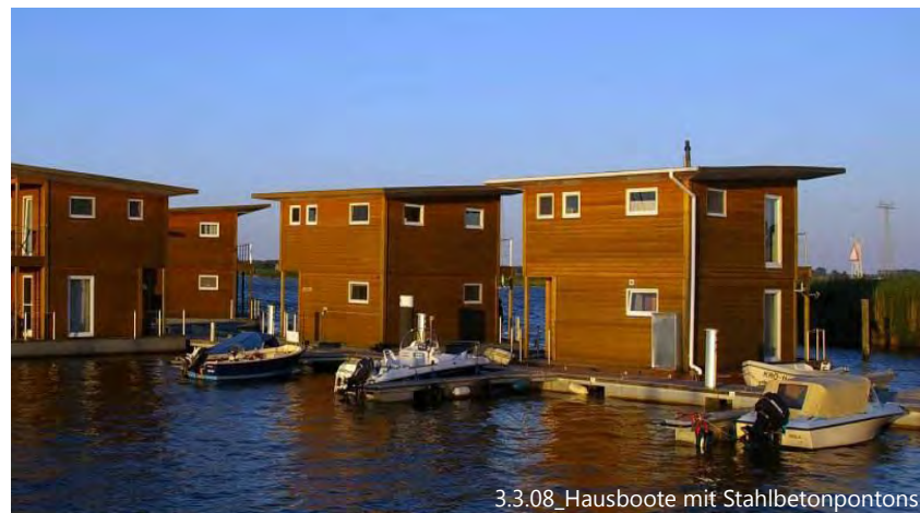
3.3.08_Hausboote mit Stahlbetonpontos
