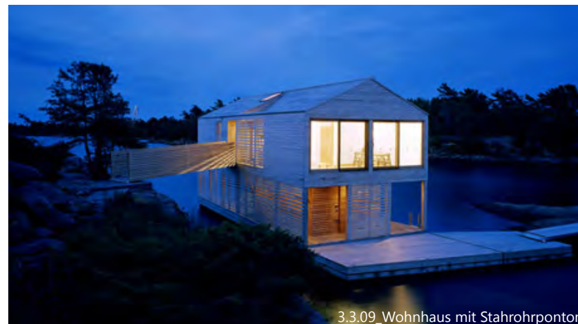
3.3.09_Wohnhaus mit Stahrohrponton
