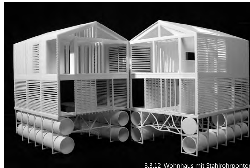
3.3.12_Wohnhaus mit Stahrohrponton
