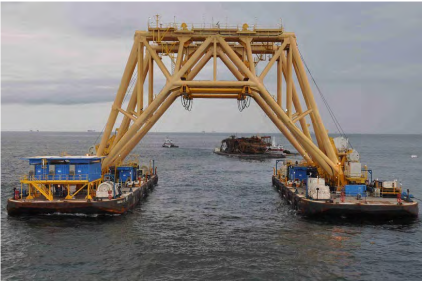
3.3.14_Kran auf Stahlpontons
