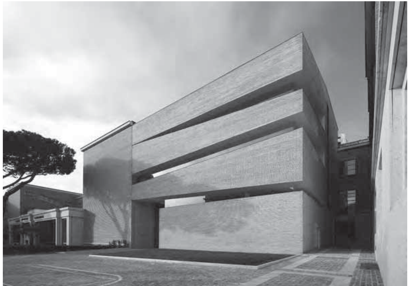
Abb. 4_12: Außenfassade der Bibliothek mit Fenstereinschnitten
