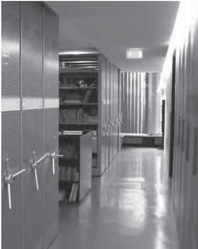
Abb. 3_14: Elektrisch betriebene Compactus-Regale
