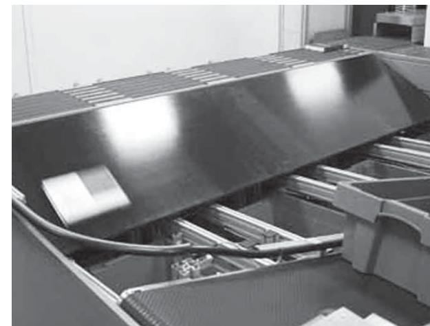
Abb. 3_17: Bücherrutsche Abb. 3_18: Förderbandanlage
