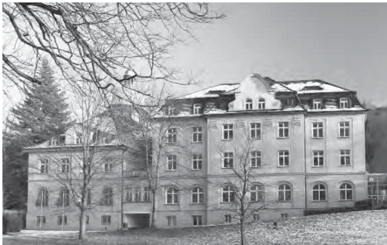
Abb. 5_17: Mittel- und Vervindungstrakt
