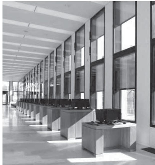
Abb. 6_02: Sensorgesteuerter Sonnen- und Blendschutz im Jacob-Wilhelm-Grimm-Zentrum in Berlin
