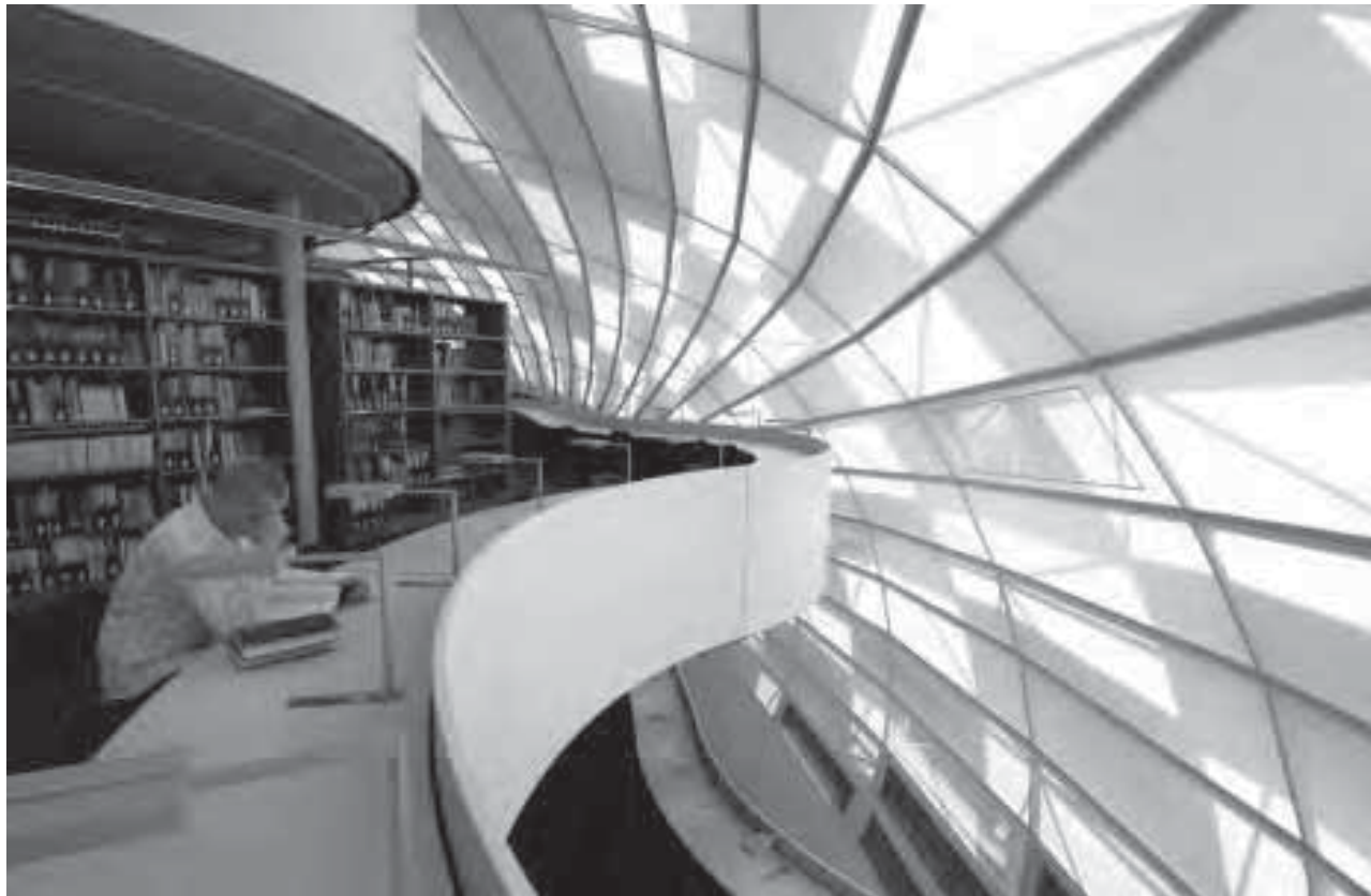
Abb. 3_27: Indirekte Tageslichtbeleuchtung durch an der Innenseite aufgespanntes beschichtetes Gewebe in der Universitätsbibliothek in Berlin
