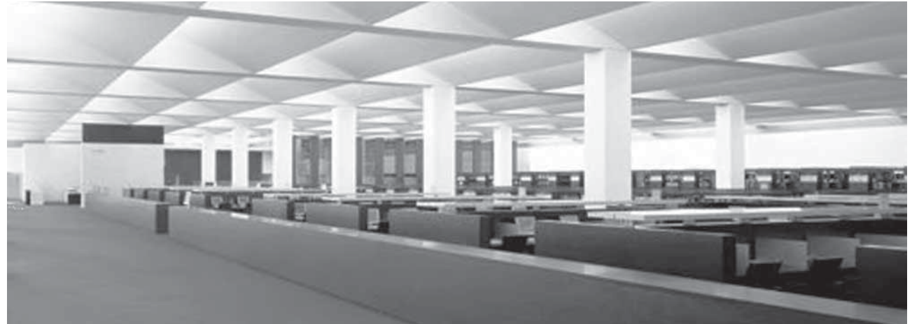
Abb. 4_03: Belichtung mit Tageslicht im Lesesaal mittels Oberlichter
