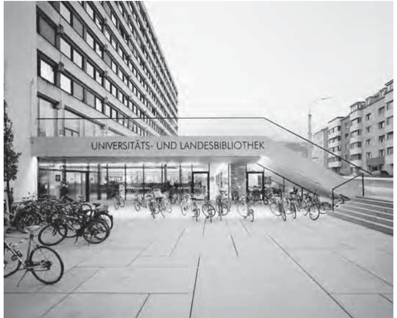
Abb. 4_16: Dach der neuen Bibliothek als Haupteingang der Universität
