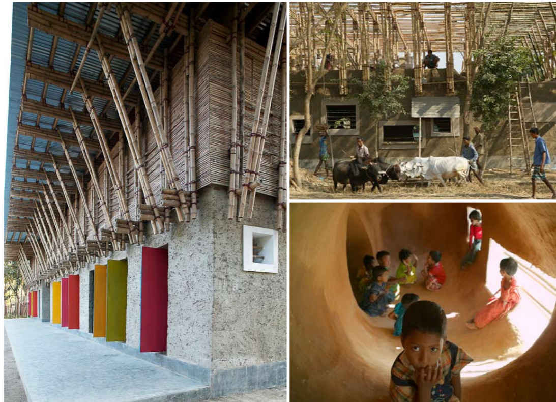
Abb.06 - 08 METI - Handmade School in Rudrapur, Bangladesch, Anna Heringer und Eike Roswag. Das 2005 errichtete Schulgebäude ist Beispielprojekt für Bauen im nachhaltigen Sinn.
