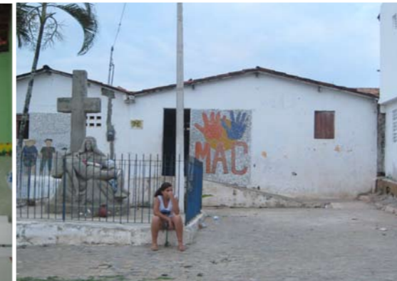
Abb.28 Die Räumlichkeiten von MAC befinden sich in einem sehr schlimmen Zustand.
