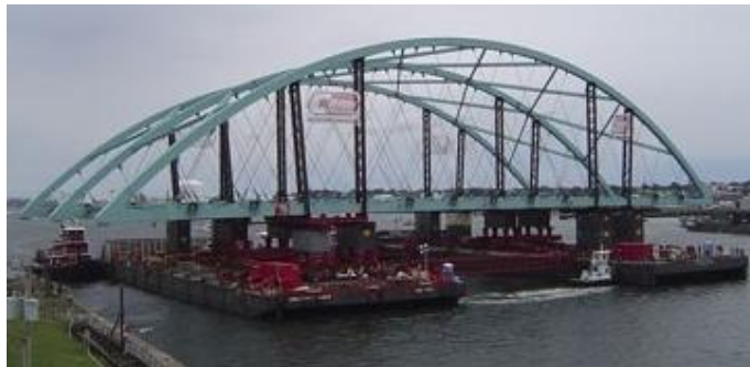
Abbildung 48 Verschiffung des fertiggestellten Brückentragwerks [ http://www.fhwa.dot.gov/publications/focus/07dec/03.cfm ]
