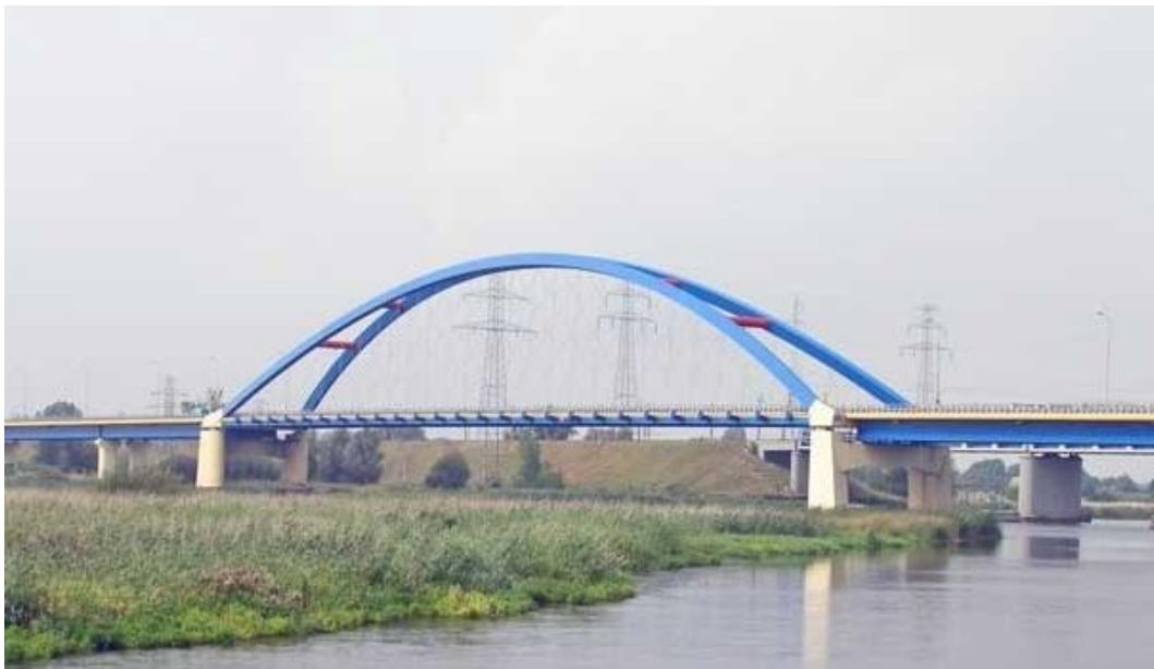
Abbildung 44 Brücke in Wolin [ http://erwin-rosenthal.de/vorpommern/Die%20Stadt%20Wollin.htm ]
