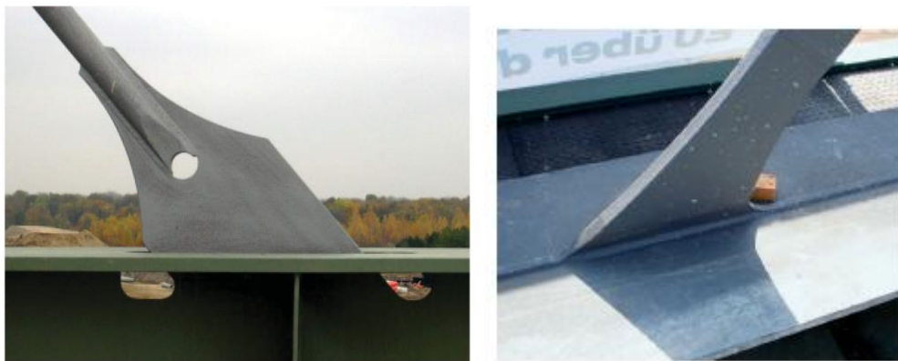
Abbildung 39 Anschlussmöglichkeiten für einen Versteifungsträger mit I-Profil
