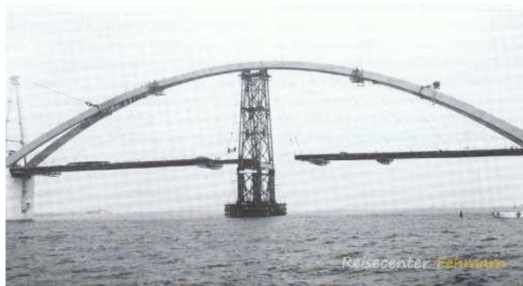
Abbildung 43 Bau der Fehmarnsundbrücke [ http://www.reisecenter-fehmarn.de ]
