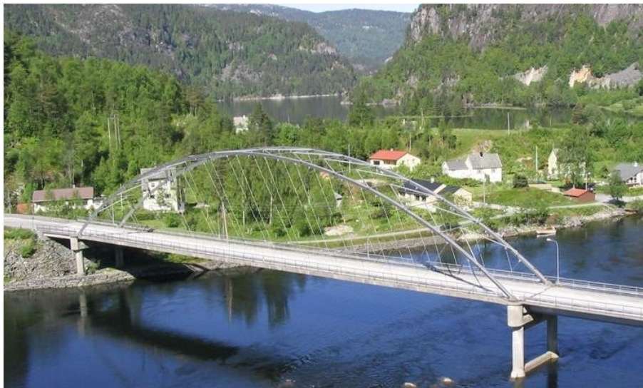
Abbildung 4 Brücke über den Bolstadstraumen [2]
