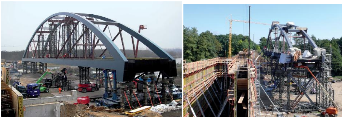
Abbildung 41 Montagezustände verschiedener Brücken [5]
