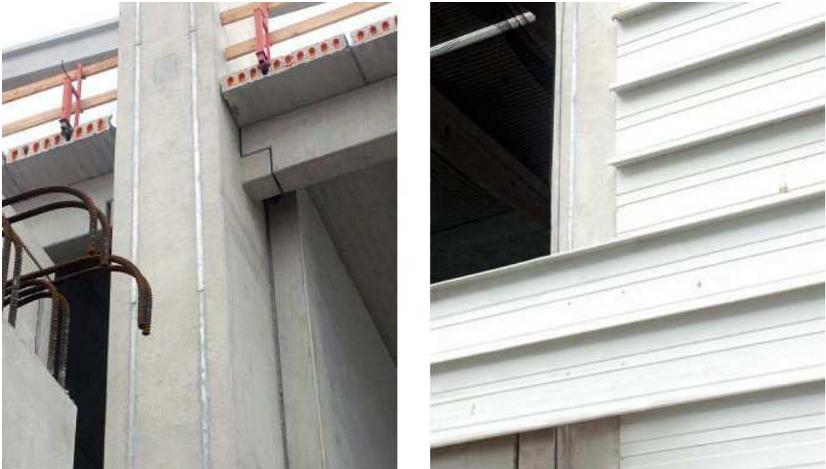
Abb. 4.16: Schienen zur Befestigung der Fassadenbekleidung (li.) und montierte Fassadenbekleidung (re.) aus [14]
