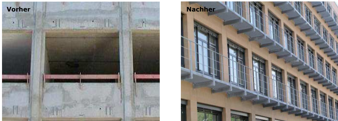
Abb. 4.6: Befestigung von Fluchwegen nach [14]
