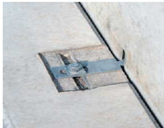
Abb. 4.8: Anschluss Wand an Stütze mit Luftspalt (li.) und Wand an Decke (re.) aus [12]
