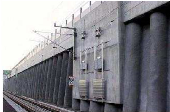
Tunnelbau: Befestigung von Fahrleitungsspanner
