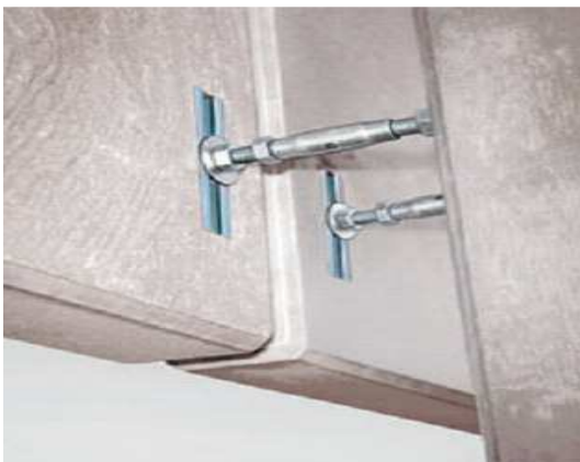
Abb. 4.8: Anschluss Wand an Stütze mit Luftspalt (li.) und Wand an Decke (re.) aus [12]
