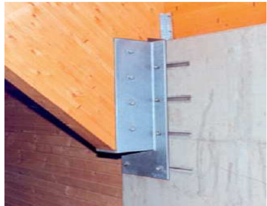
Abb. 4.11: Befestigung von Holzbalken mit Nagelanschlussanker (li.) und Balkenschuh an Stahlbetonwand (re.) mittels Ankerschiene aus [14] [12]
