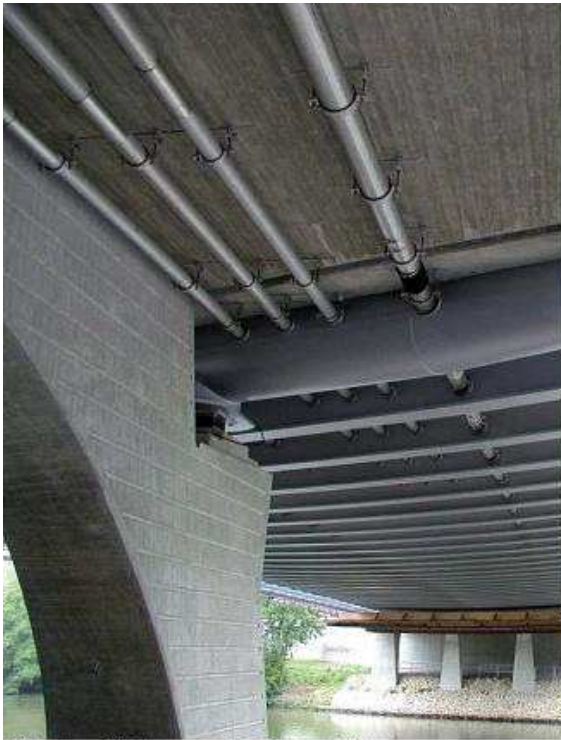
Brückenbau: Befestigung von Entwässerungsleitungen
