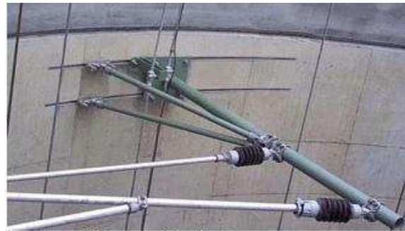
Tunnelbau: Befestigung von Oberleitungen
