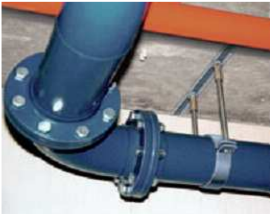
Abb. 4.14: Einzelbefestigung an der Decke (li.) und Sammelbefestigung mit Konsole an der Wand (re.) aus [12] [11]
