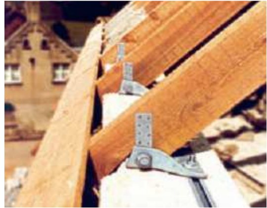
Abb. 4.10: Konventionelle Fußpunktausbildung (li.) und Sparrenfuß angeschraubt an einbetonierter Ankerschiene (re.) aus [19] [12]
