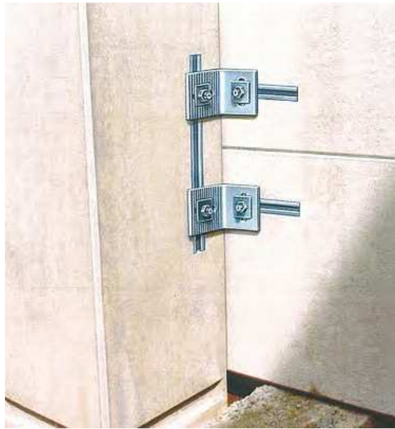
Abb. 4.7: Verbindung mittels Ankerschienen und Winkel aus [11]
