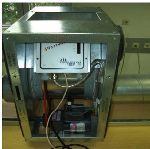
Abbildung 80: Rotationswärmetaucher mit Antrieb und Drehzahlregelung
