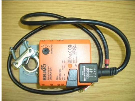
Abbildung 87: Stufenloser Stellantrieb für die Lüftungsklappe
