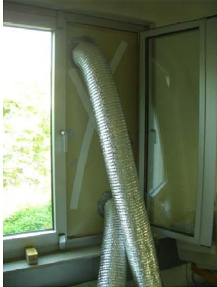
Abbildung 104: Anschlußstelle Außen- und Abluftkanal der Lüftungsanlage
