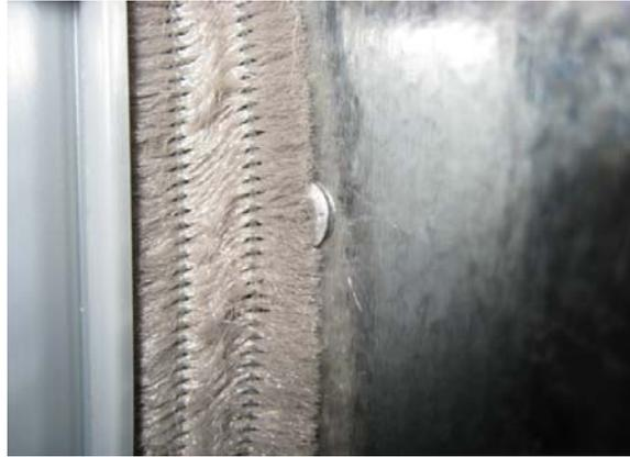
Abbildung 76: Externe Leckagen durch einen Mangel in der Fertigung des Rotationstauschers
