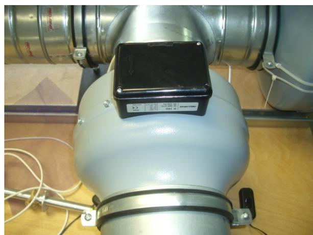
Abbildung 84: Radial-Rohrventilator K 160
