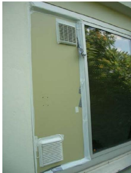
Abbildung 105 Ansaug- und Ausblasöffnung mit Wetterschutzgitter
