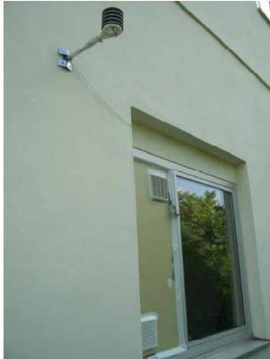
Abbildung 106: Positionierung der Außenluftfühler für Temperatur und Feuchte
