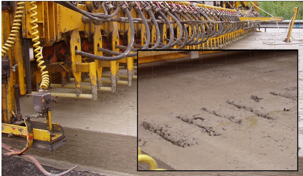
Abbildung 5.43: Beispiel für ein Setzgerät zum Einbau von Dübel
