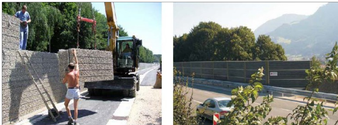
Abbildung 3.18: Beispiele für Lärmschutzwände aus gefüllten Stahlkörpern [10]
