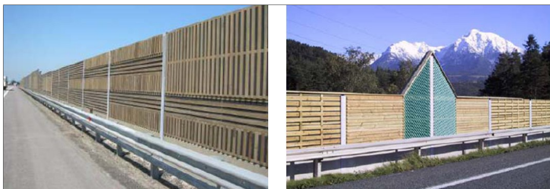
Abbildung 3.16: Beispiele für Lärmschutzwände aus Holz [10]
