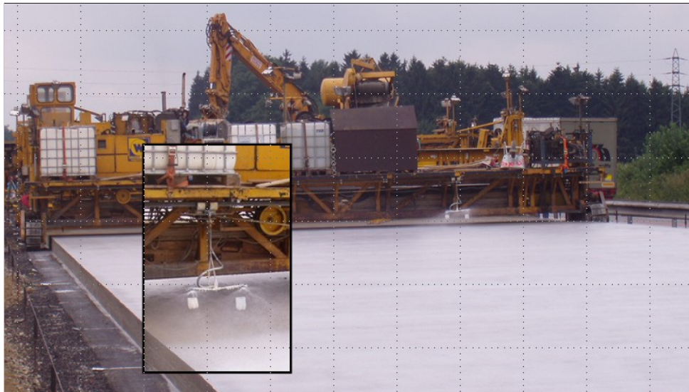
Abbildung 5.45: Aufbringen eines Kontaktverzögerers auf den Oberbeton
