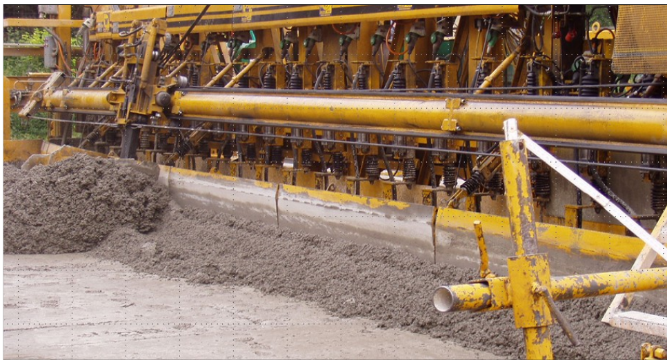
Abbildung 5.44: Beispiel eines Gleitschalungsfertigers für den Einbau einer Betondecke
