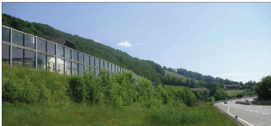
Abbildung 3.29: Wohnhausseitige Lärmschutzwand an der A1 - West Autobahn [65]
