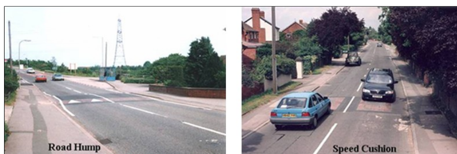
Abbildung 3.31: Beispiele von Fahrbahnschwellen in Gloucester - Großbritannien [69]
