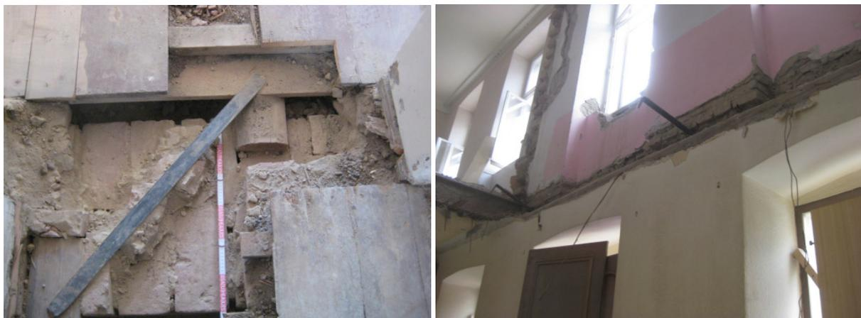
**Abbildung 2.4:** Verschleißungen am Objekt Spittelbreitengasse 30, im Bereich der Decke über 1. OG (Bild links), Mittelmauer, und im Bereich der Decke über EG, tragende Außenmauer (Bild rechts).
