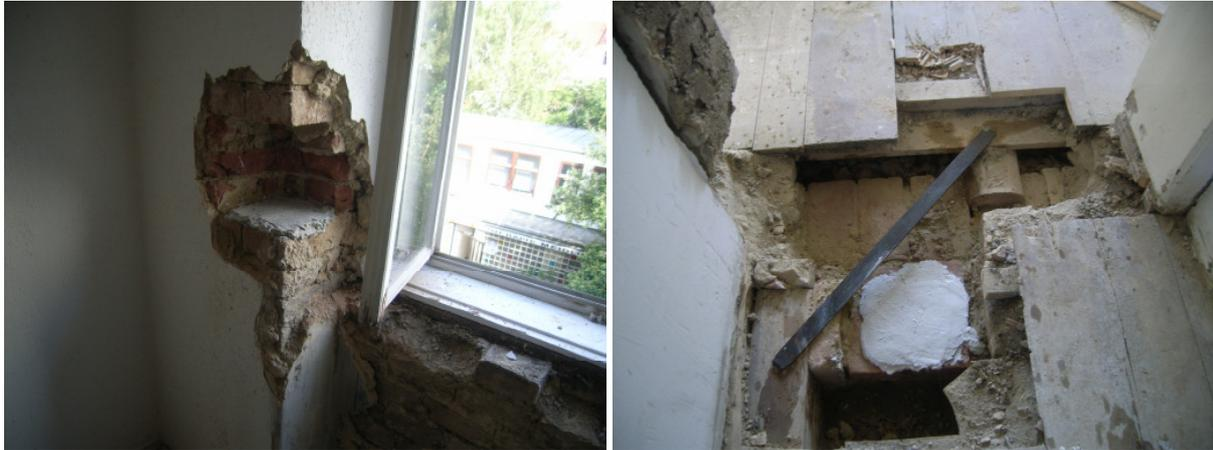
**Abbildung A 12:** Vorbereitung der Positionen für die Beschleunigungsaufnehmer.
