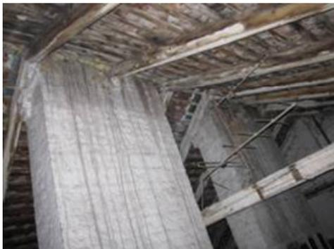
Wasserflecken am Kaminmauerwerk und der Dachkonstruktion
