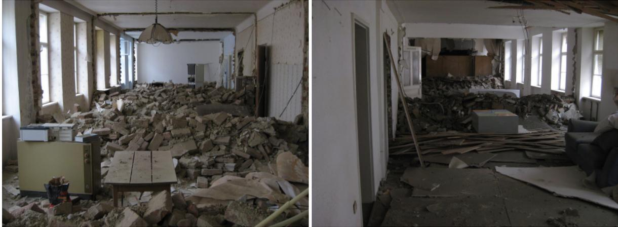
**Abbildung 3.41:** Testobjekt Spittelbreitengasse – Innenansicht nach Entfernen der Zwischenwände im 1. Obergeschoß (links) und 2. Obergeschoß (rechts).
