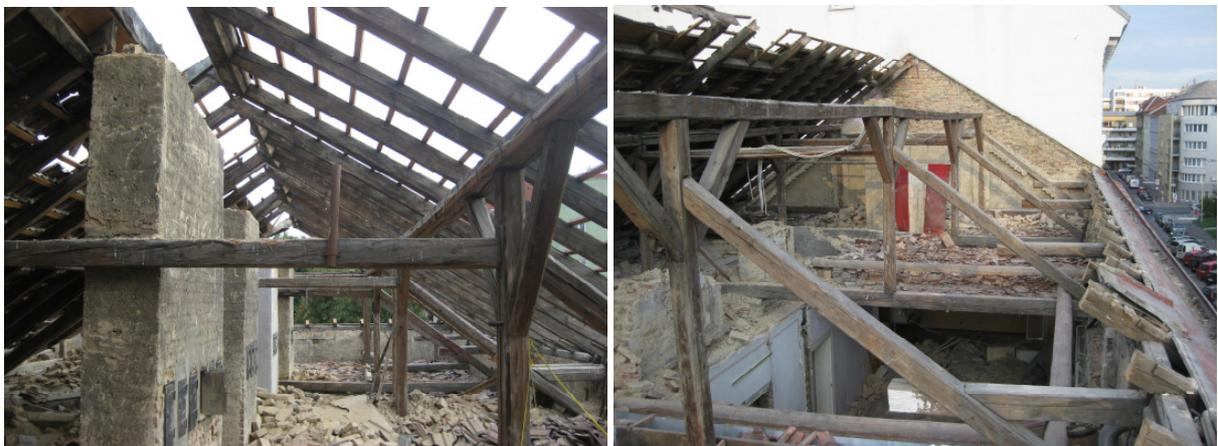
**Abbildung 3.42:** Testobjekt Spittelbreitengasse – Ansicht nach teilweisen Entfernen der Dachkonstruktion Trakt Singrienergasse (links) und Trakt Spittelbreitengasse (rechts).
