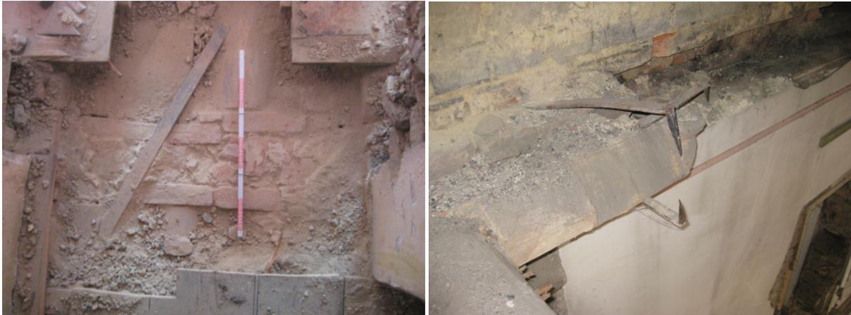
**Abbildung 3.38:** Testobjekt Spittelbreitengasse – Verbindungen zwischen Holzbalkendecken und tragenden Mauerwerkswänden.
