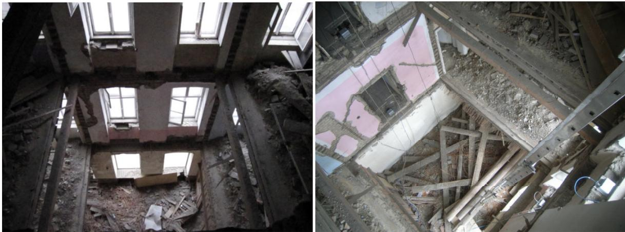
**Abbildung 3.37:** Testobjekt Spittelbreitengasse – Innenansicht nach Entfernen der Decken- und Zwischenwandelemente.
