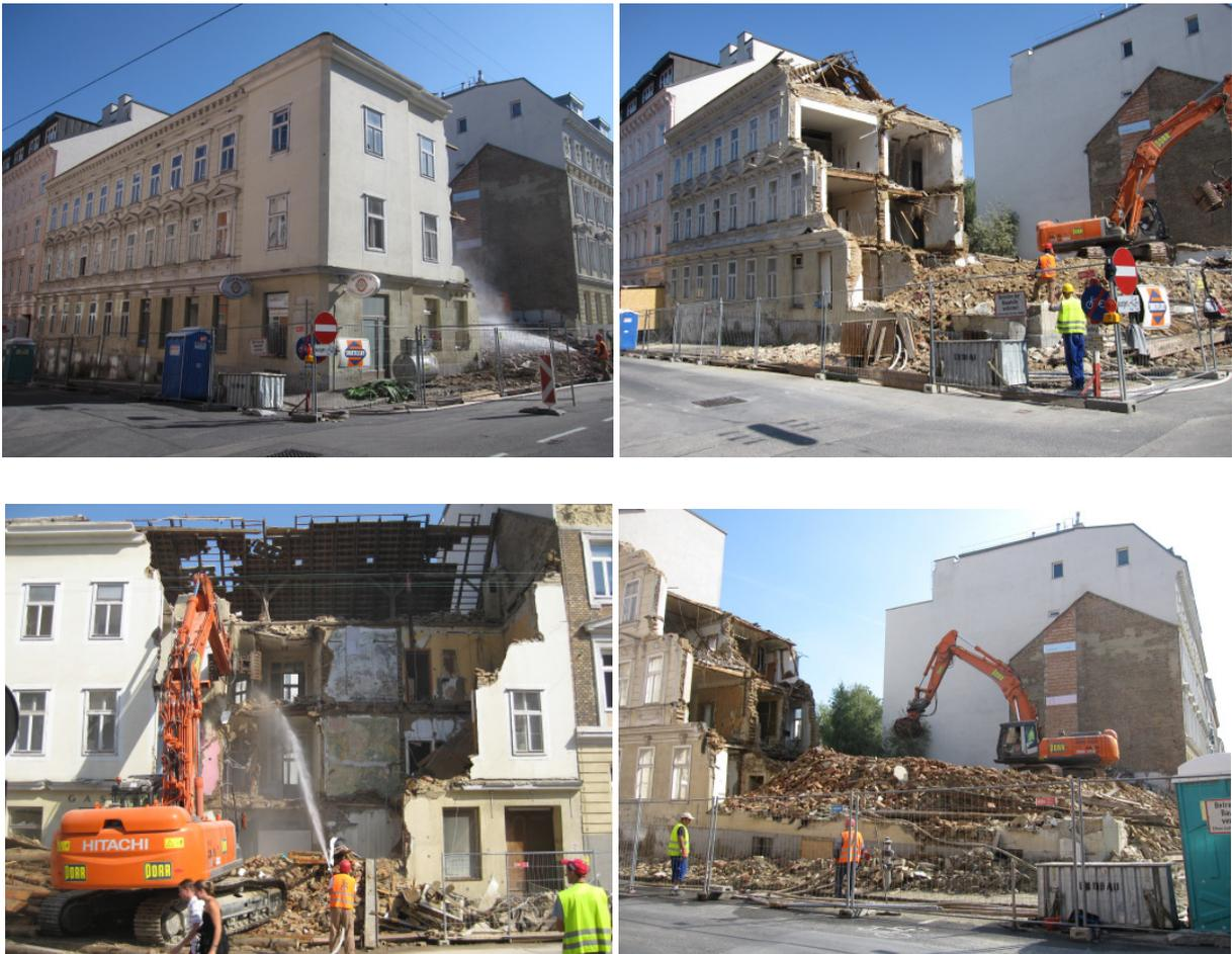
**Abbildung A 15:** Phasenweiser Abbruch des Gebäudes Spittelbreitengasse 30.
