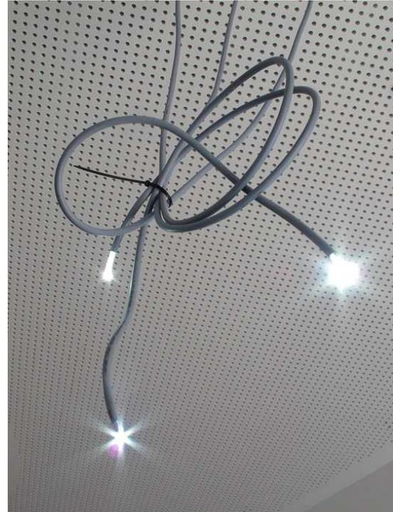
Abb. 33 und 34: Heliostatenanlage am Dach, Glasfaserkabel im Foyer
