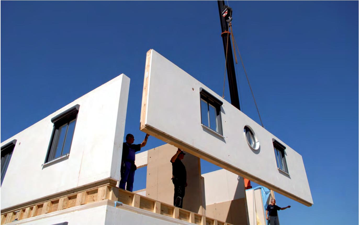
**Abb. 2.1** | Montage eines Fertighauses
