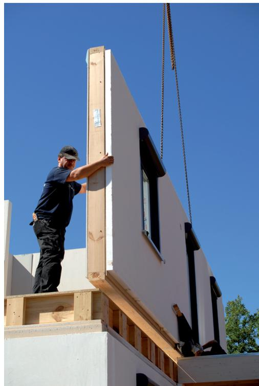
**Abb. 2.2** | Montage eines Fertighauses
