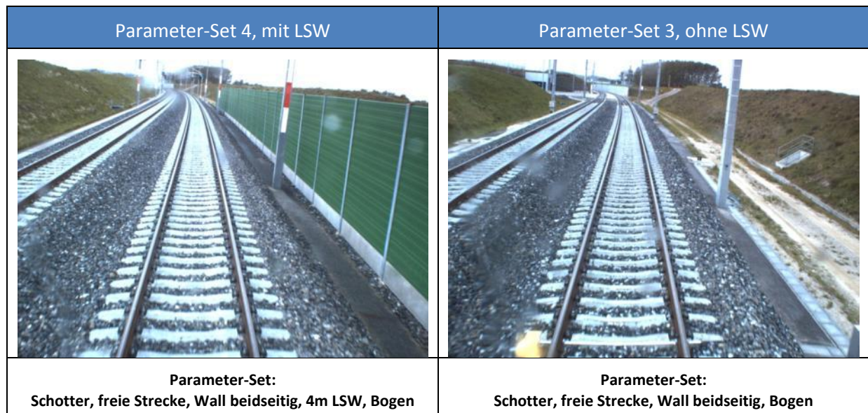
Abb. 38. Streckenbilder der Abschnitte mit und ohne Lärmschutzwand
