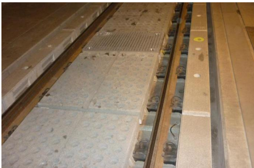
Abb. 15. Feste Fahrbahn mit Gleisabsorber im WWT-Tunnel
