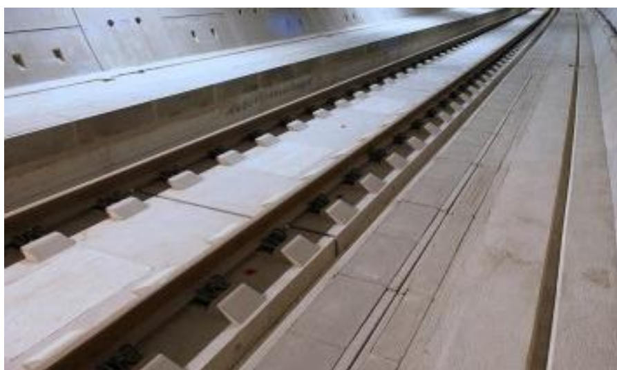
Abb. 14. Feste Fahrbahn System ÖBB/Porr (Quelle: Porr AG)
