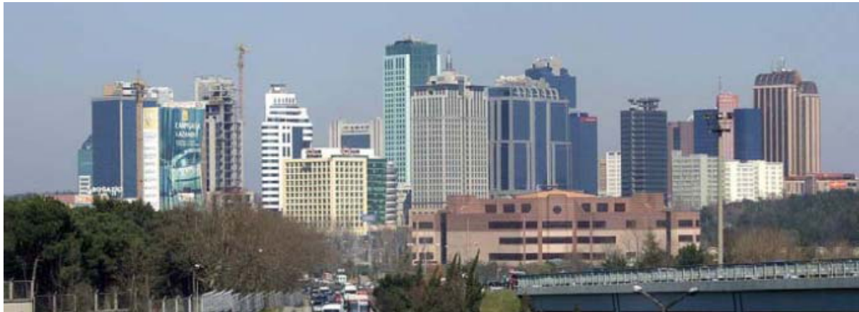
Abbildung 43 Hochhäuser an der Levent - Maslak - Besiktas Achse (27 S. 42)
