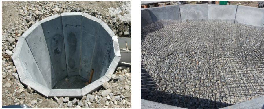
Abbildung 3.12: Festbett-Speicher mit Schüttung; Quelle:[15]
