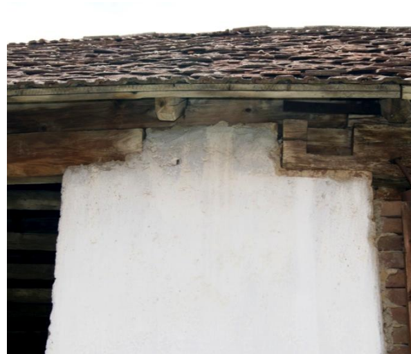
Abbildung 80: Holzüberlager der Stadttore und Wiener Taschen am Stadl
