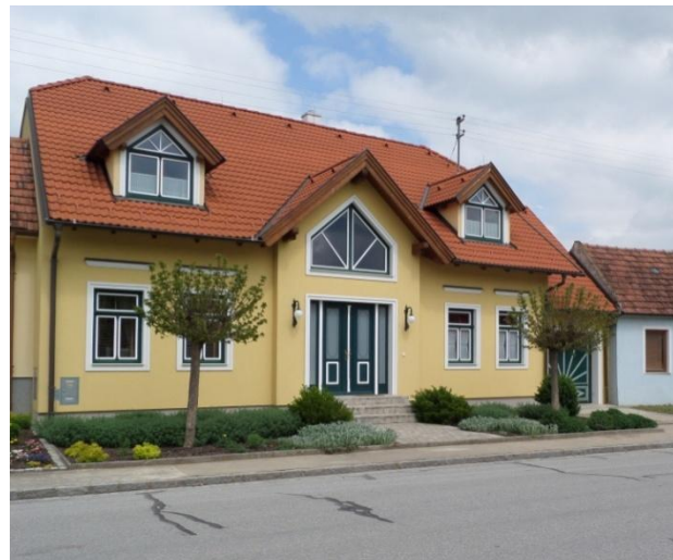
Abbildung 45: wuchtiger Neubau mit Gaupen neben eingeschossigem Gehöft, Althöflein
