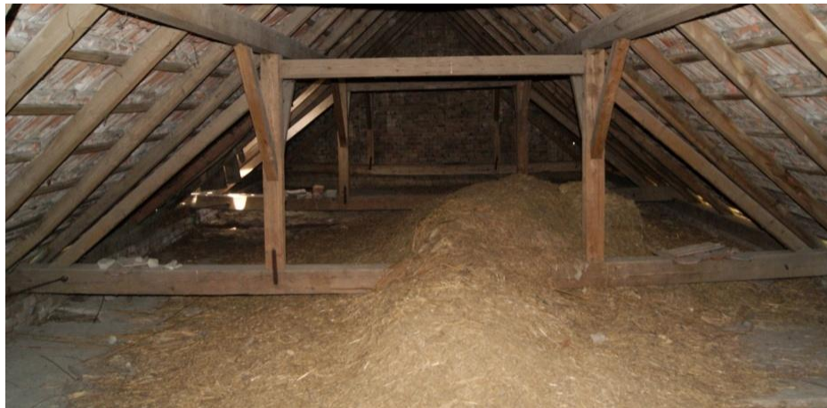
Abbildung 110: Hängender Dachstuhl über den Stallungen, Althöflein 104
