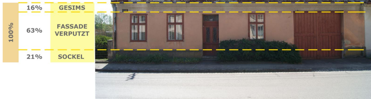
Abbildung 108: Gliederung der Straßenfassade, Althöflein 104
