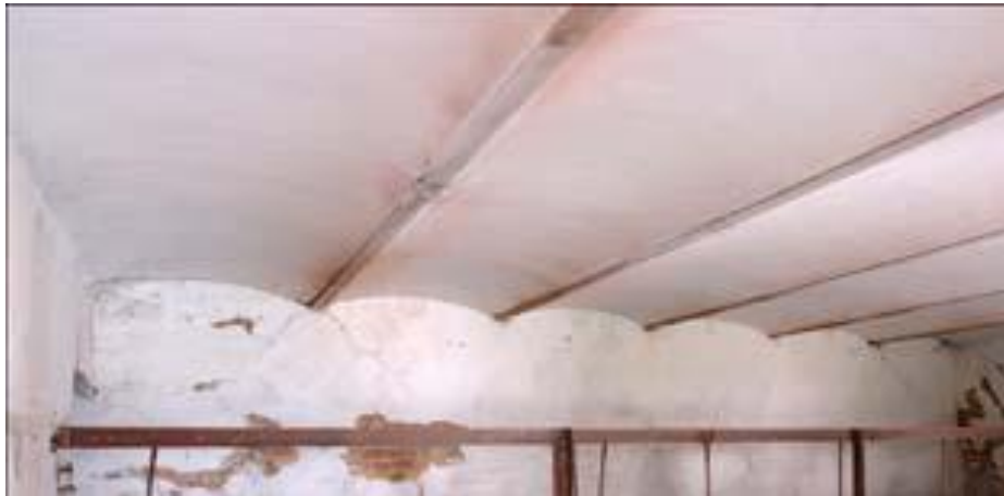
Abbildung 19: Preußische Kappendecke eines Viehstalls
