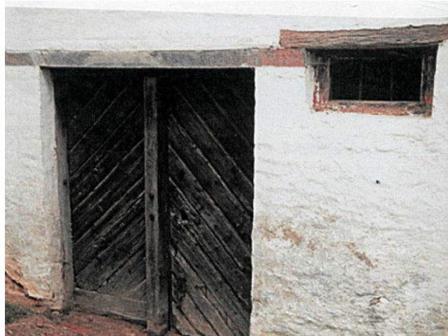
Abbildung 17: sichtbare Holzüberlager
