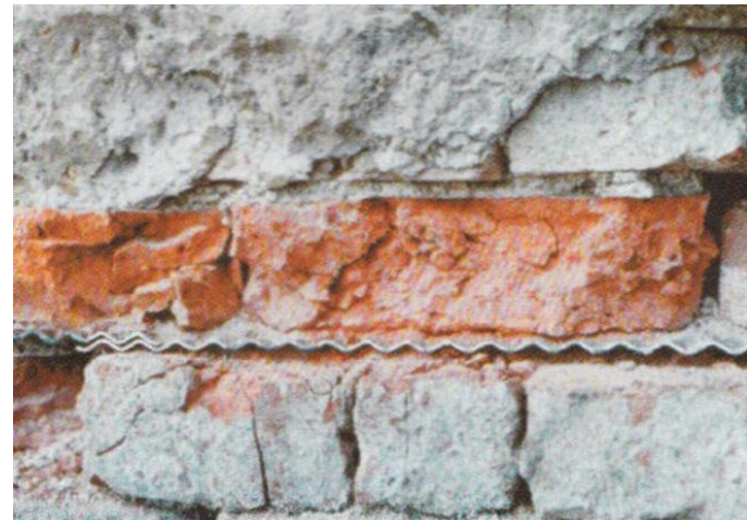
Abbildung 107: Mechanisches Verfahren, Horizontalabdichtung mittels gewellter Edelstahlplatten
