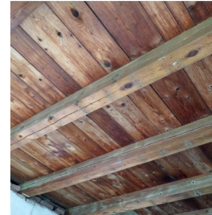
Abbildung 78: Tramdecke über der Einfahrt
