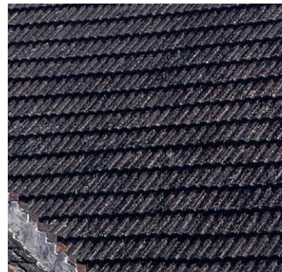
Abbildung 22: Falzziegeldeckung
