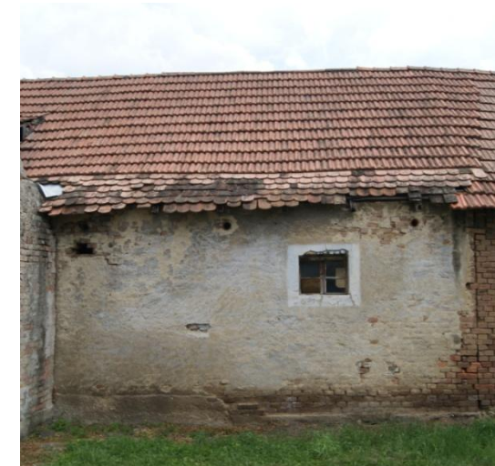
Abbildung 81: Ausbesserungen an der Rückwand der Stallungen
