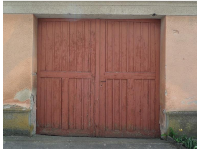
Abbildung 72: Einfahrtstor an der Straßenfassade
