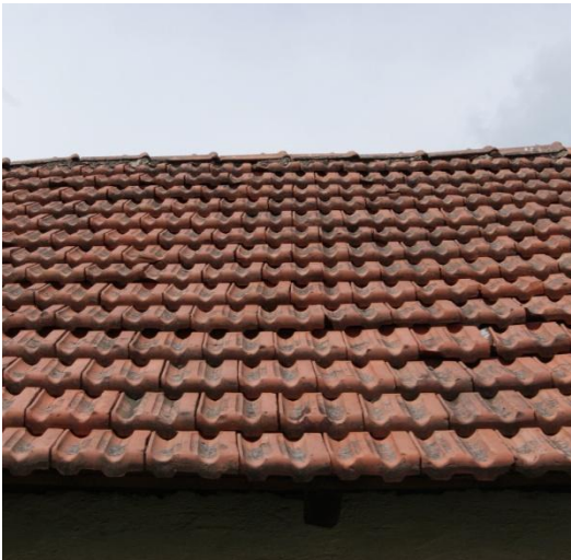
Abbildung 79: Falzziegeldeckung am Wohntrakt und den Stallungen
