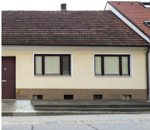
Abbildung 44: Überdimensionierung der Fensteröffnungen, Althöflein
