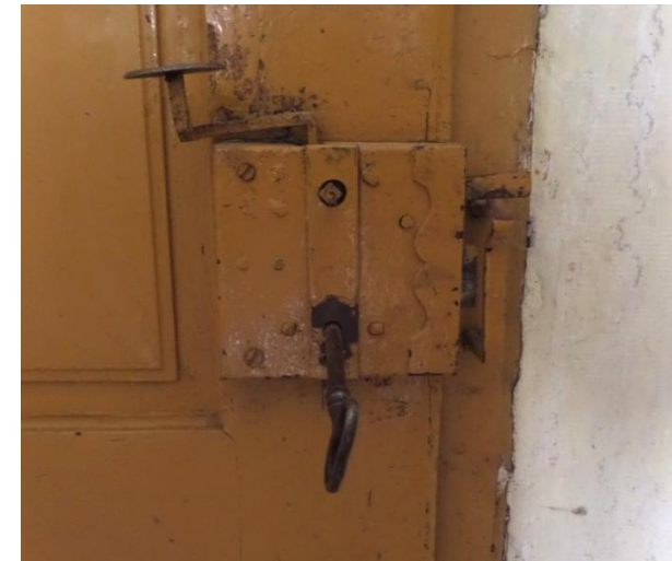
Abbildung 74: Innenseitiger Beschlag an der Hoftür
