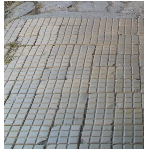
Abbildung 115: „Schattauer Pflaster“ im Bereich der „Trettn“, Althöflein 104
