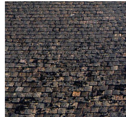
Abbildung 23: Doppeldeckung in Wiener Taschen
