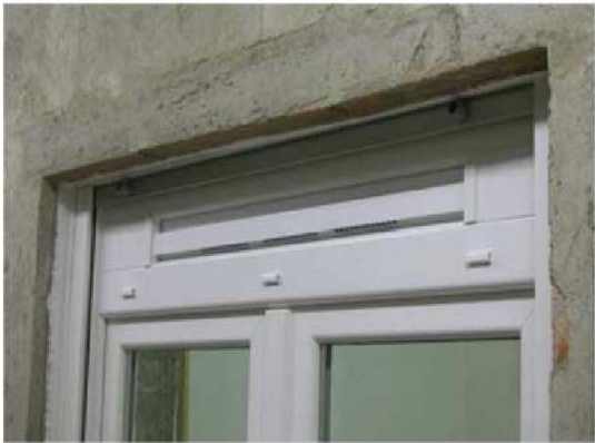
Abb. 11: Aerator im Einbauzustand [Asdrubali & Buratti 2005]
