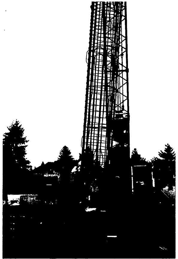
Abb. 147. Einbau eines mit Absorberleitungen bestückten Bewehrungskorbes (unterer Schuss).
