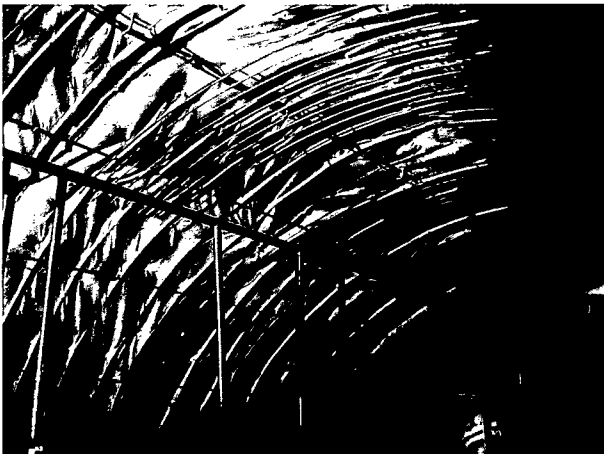
Abb. 284. Einbau der äußeren Bewehrungslage im Bereich der Firste.
