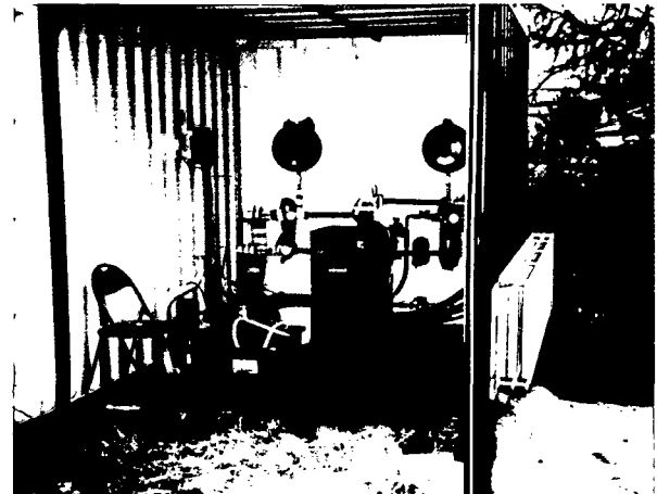
Abb. 111. Versuchsanlage nach dem Umbau. Der Radiator wurde an der Außenwand des Containers befestigt.
