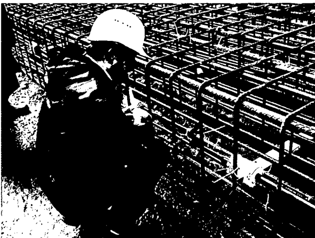
Abb. 208. Die einzelnen Segmente des Kettenextensometers werden an den Bügeln auf der Stirnseite des Schlitzwandbewehrungskorbes montiert. Die Befestigung des Kettenextensometers erfolgt in einem Abstand von ca. 5 cm von der Bewehrung mit Hilfe eines Abstandhalters (Pfeil). Dieser Sicherheitsabstand ist einzuhalten, damit das Gestänge von den Verschiebungen der einzelnen Bügeln, die vor allem beim Aufheben des Bewehrungskorbes entstehen, entkoppelt ist.
