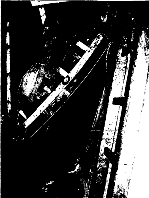
Abb. 290. Unterstes (bewegliches) Element des Schalungswagens. Beim Schließen dieser Schalungseinheit wird die Sammelleitung durch eine vorbereitete Öffnung eingefädelt.
