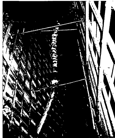
Abb. 287. Durchführung der Sammelleitung im Block 43(links) und Block 41(rechts). Am jeweils linken Bildrand befindet sich die Außenschale, am rechten Bildrand der Tunnelinnenraum. Die Absorberleitungen sind etwa 1,5 m zwischen äußerer und innerer Bewehrungslage geführt, um möglichst lange Wasserwege zu erreichen. Zusätzlich wird ein Mauerkragen eingebaut und die Absorberleitung davor (Block 43) und dahinter (Block 41) mit einem Nachverpressschlauch umwickelt. Mit dieser unterschiedlichen Belegung soll die optimale Ausführung für die Innenschalendurchdringung erprobt werden.
