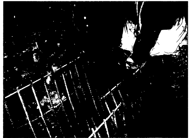
Abb. 285. Einbau der äußeren Bewehrungslage im Bereich der Sohle. Die durch die Innenschale führende Sammelleitung wird eingefädelt.
