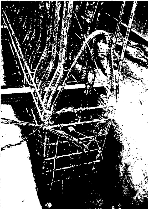
Abb. 218. Blick auf das obere Ende (Stosstelle) des eingebauten unteren Bewehrungskorbes. Die Prüfleitungen sind bereits herausgeführt.
