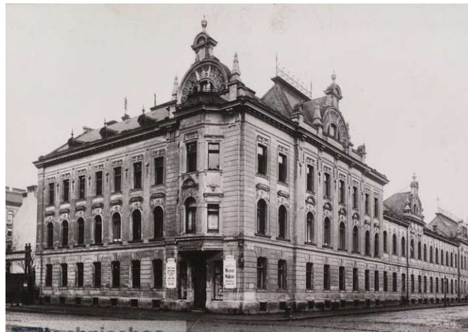
Fig. 30 New Dairy headquarter in today's Molkereistraße, ca. 1910 ©technisches museum wien
