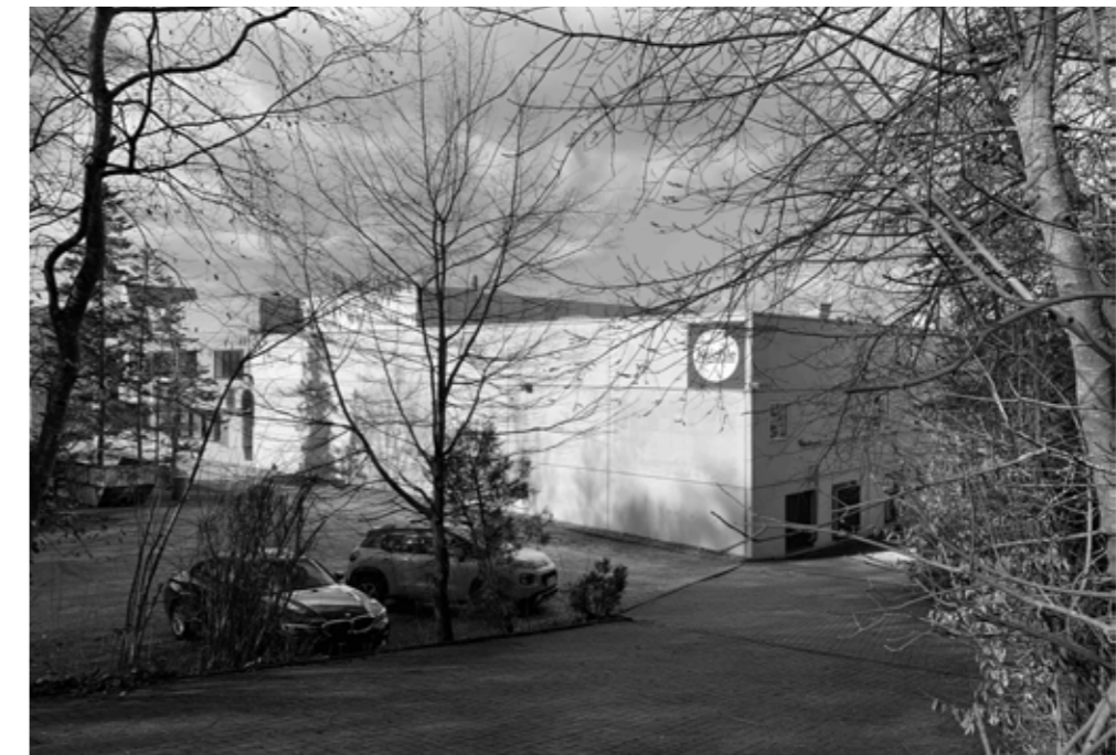
Abb. 64 Oblatenfabrik Kuchle, Ansicht Süd-Ost
