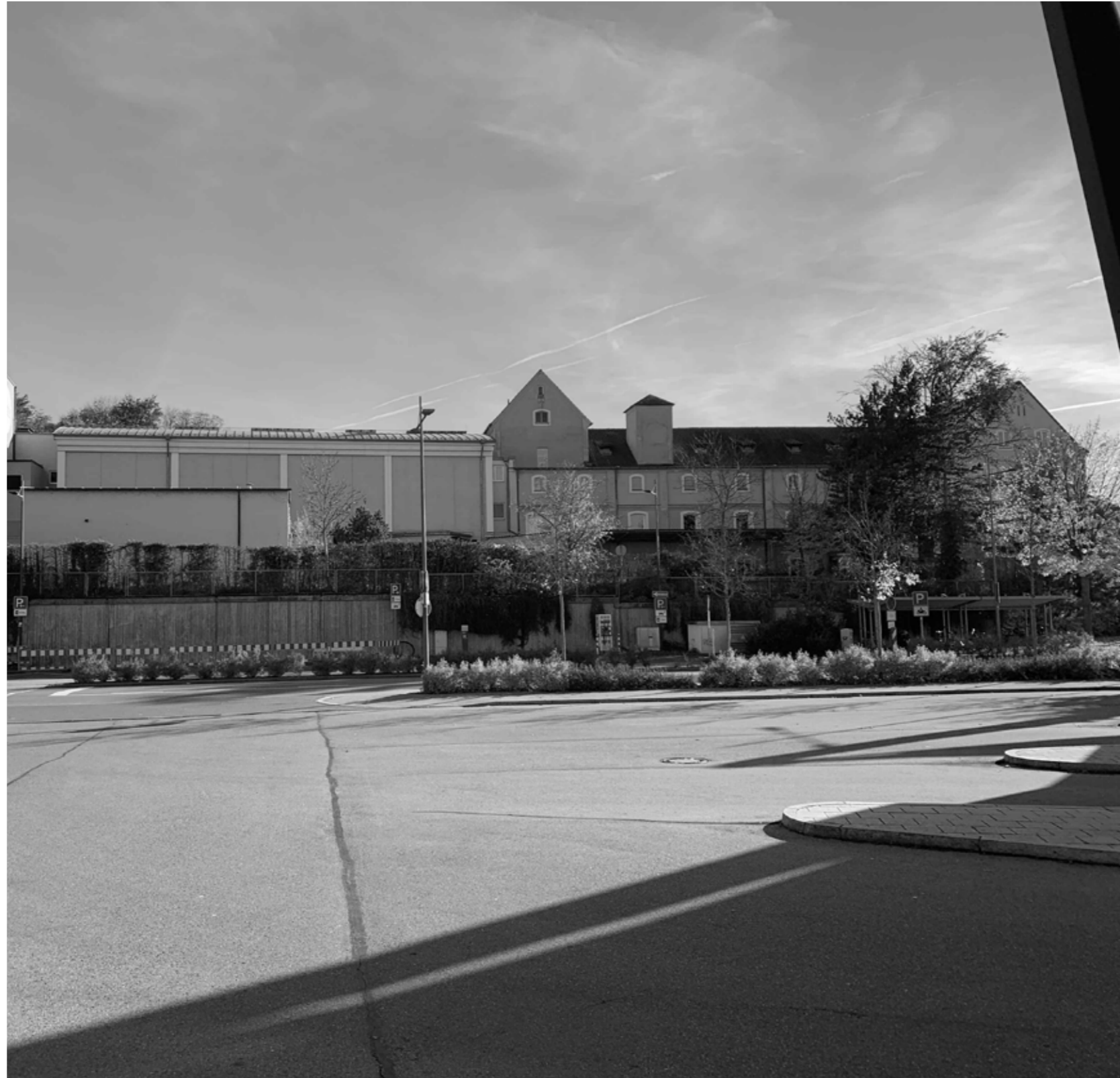
Abb. 60 Oblatenfabrik Kuchle, Ansicht Norden
