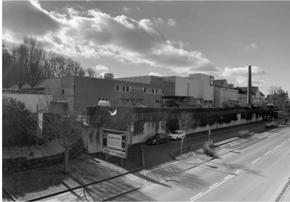
Abb. 61 Oblatenfabrik Kuchle, Ansicht Nord-Ost
