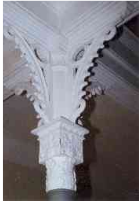
Abb. 44 Detailansicht Auflager im Emporengeschoß um 2002 (Quelle: Libor Raclavský Orthodoxe Kirche Přerov)
