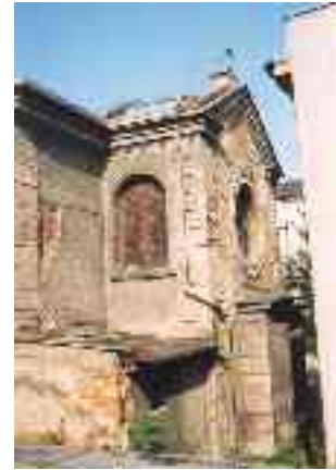
Abb. 39 Aussenansicht Zugangsseite vor der Renovierung (Quelle: Libor Raclavský, Orthodoxe Kirche Přerov)
