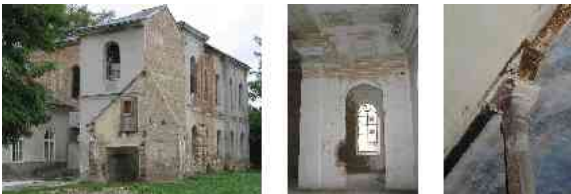
Abb. 33 Fotos am 06.10.03 aufgenommen von links nach rechts Hofansicht, Emporen Stiegenhauszugang und Erdgeschoß gusseiserne Stütze
