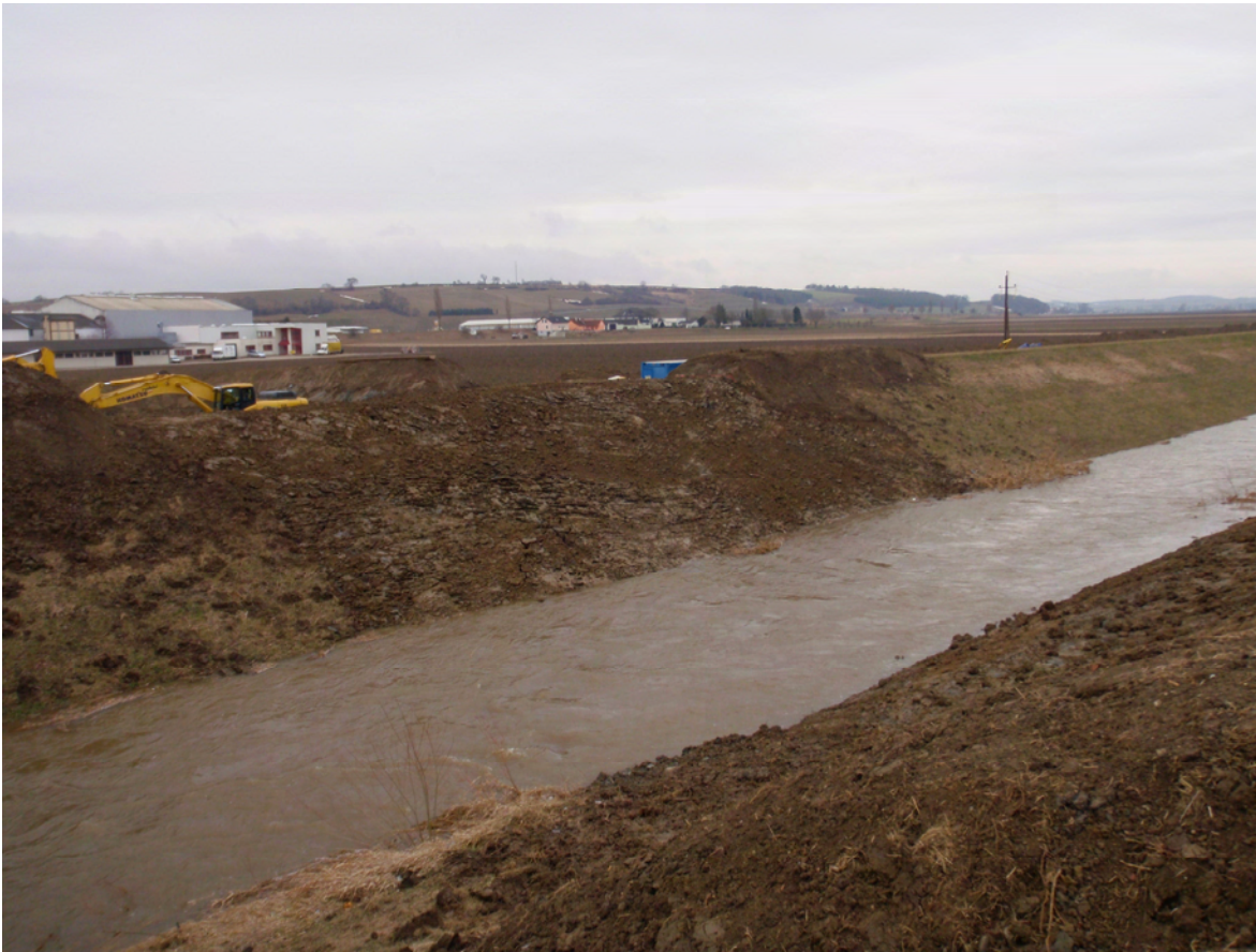
Abb. 4 Hochwasser Entlastungserinne Perschling
