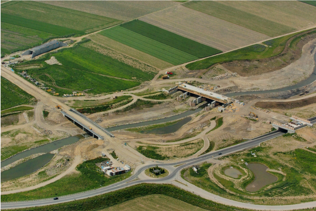
Abb. 2: Photo der Baustelle Querung der Großen Tulln bei Judenau
