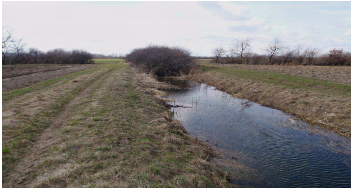
Abb. 5 Räumung der Vorfluter - Perschling
