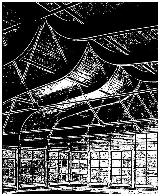
Abbildung 1.1: Ein Hallenbauwerk mit tragender Holzkonstruktion (Ruderpavillon in Linz, hergestellt vom Holzbauunternehmen WIEHAG in Altheim, Oberösterreich)
