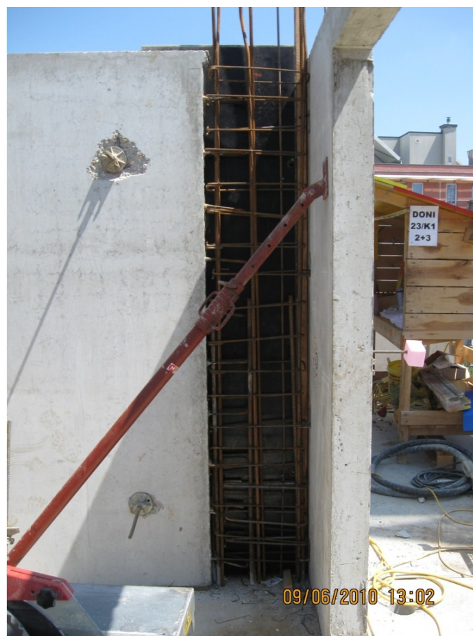
Abbildung 5.10: Zugbänder in Ortbetoneergänzungen [41]
