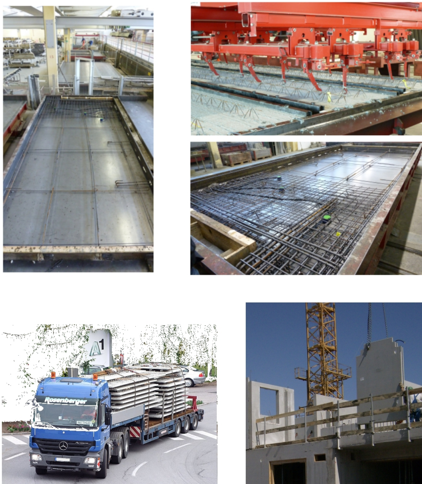
Abbildung 1.10: Produktion, Transport und Montage von Betonfertigteilen [43]
