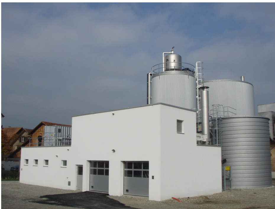
Abbildung 29: Betriebsgebäude (Vordergrund), dahinter Reaktor, rechts Nachbelüftung.
