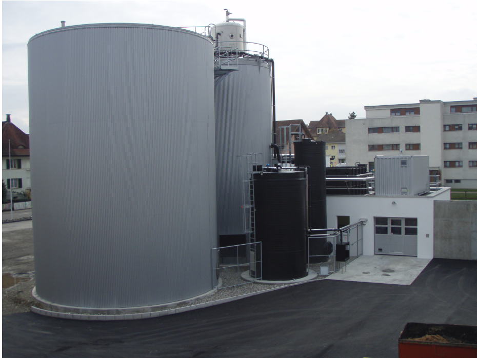
Abbildung 28: Misch- und Ausgleichsbehälter (Vordergrund), dahinter Reaktor.
