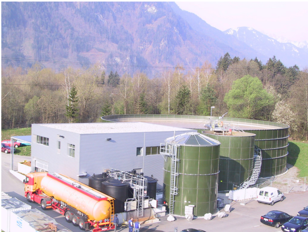
Abbildung 17: Ansicht Anlage (rechts im Hintergrund das Belebungsbecken)
