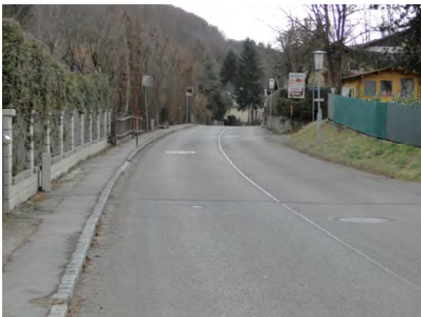
Abbildung 179: Gehsteig Pressbaum, L2111
