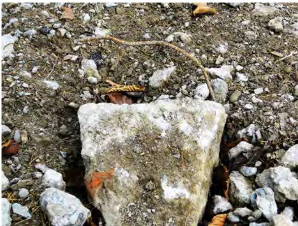
Abbildung 62: Betonbrocken mit Eisendraht
