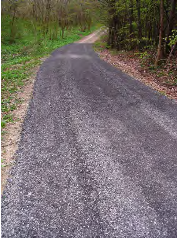
Abbildung 73: Ende der Asphaltierung
