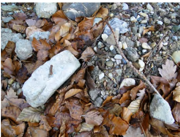
Abbildung 54: Beton mit Bewehrungseisen
