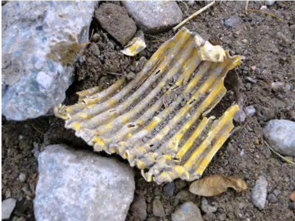
Abbildung 60: Reste von einem Drainagerohr
