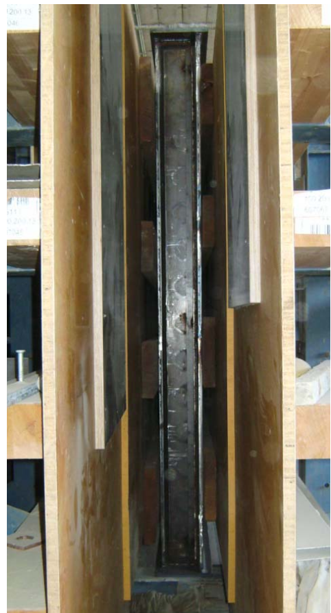
Abb. 2.5: Lagerung für Betonage
