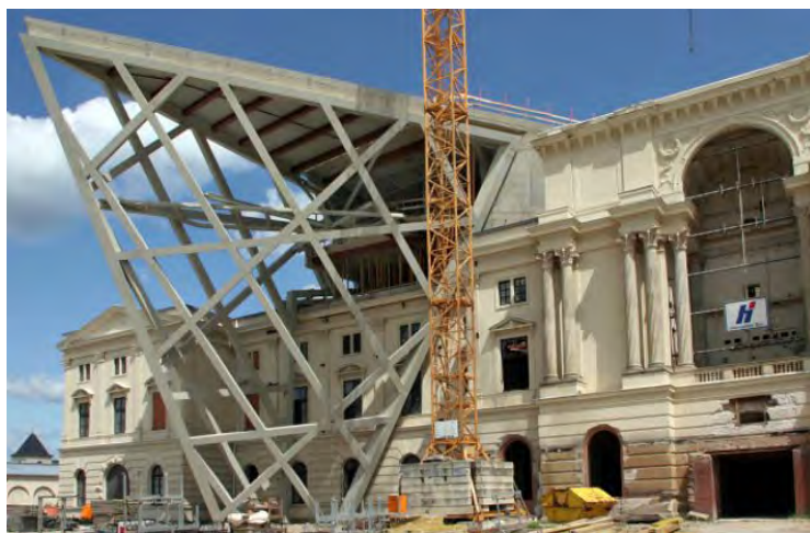
19 | Bauphase Stahlrahmen
