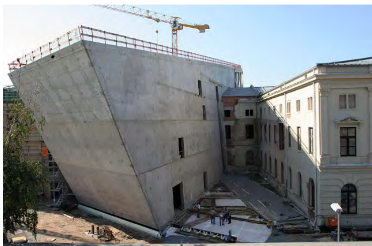
20 | Rohbau Stahlbetonwände
