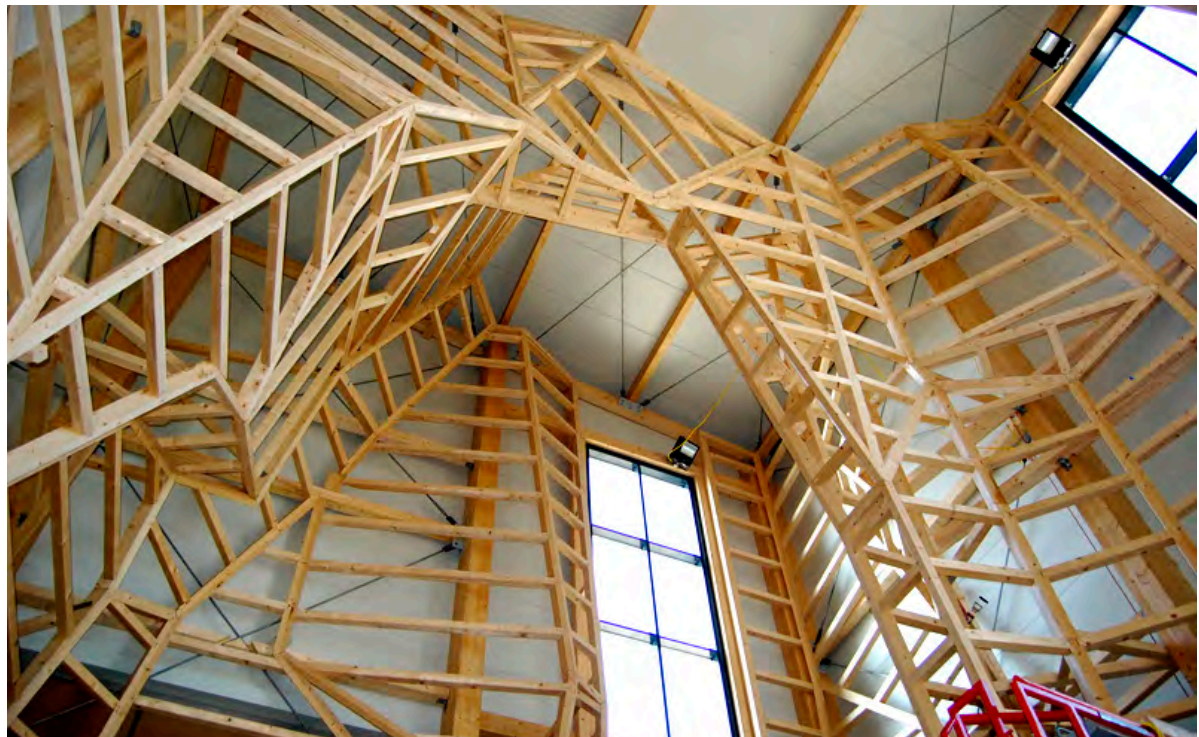
15 | Holzunterkonstruktion Kletterwand
