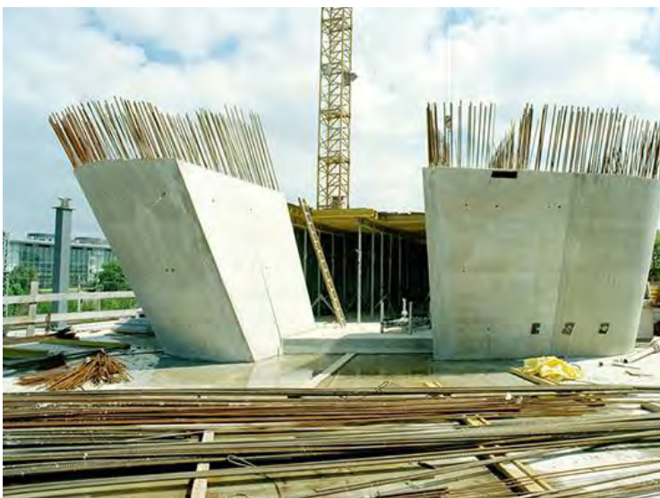
25 | Cone-Stütze ausgeschalt
