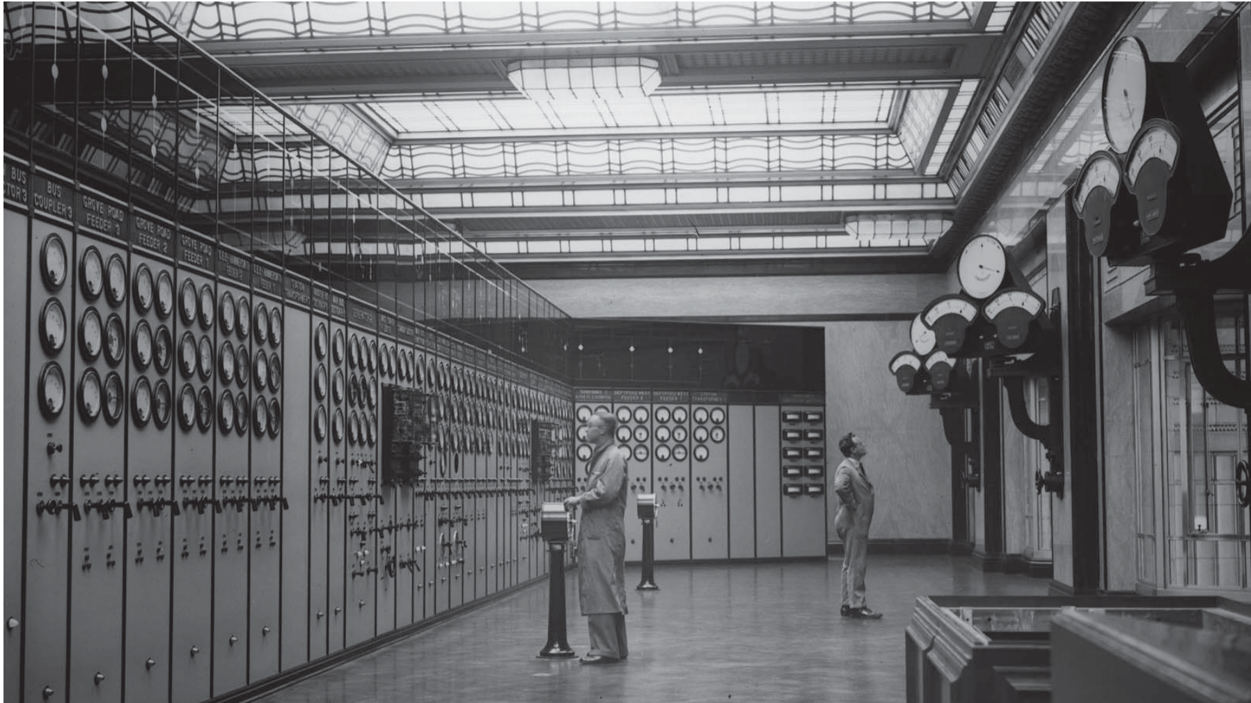
Abb. 3.13 Die Zentrale der A Station vor der Abschaltung
