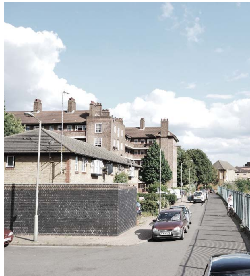
Abb. 5.6 Wohnbau auf der Stewart's Road
