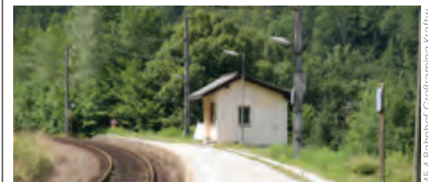
45.4 Bahnhof Großraming Kraftw.
