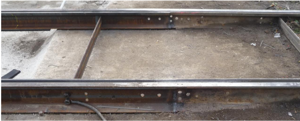
Abbildung D-19: Laschenlöcher unmittelbar neben dem Schweißstoß (Mindestabstand sollte 10 cm betragen)
