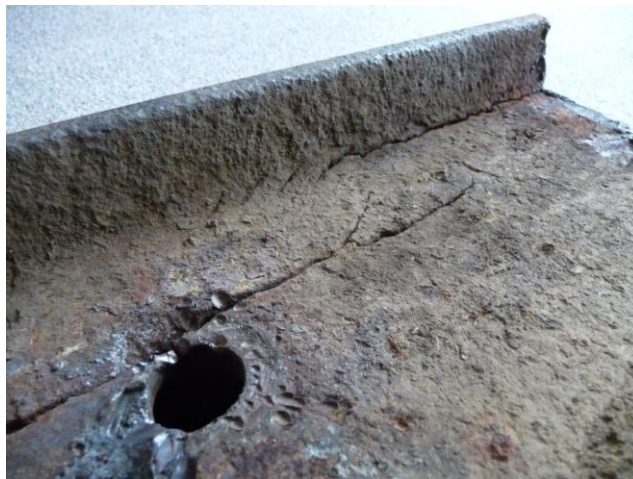
Abbildung D-12: Ermüdungsbruch unter dem Fahrkopf und vom Spurstangenloch ausgehend in einer eingebetteten Rillenschiene (im eingebauten Zustand nicht sichtbar)
