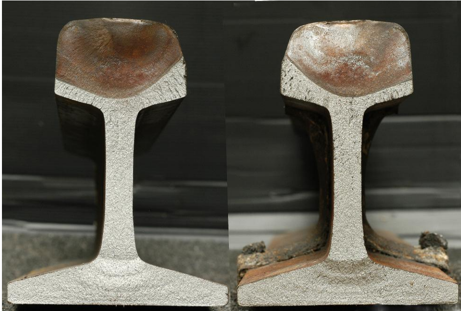
Abbildung D-7: Bruchfläche einer aufgebrochenen Schiene
