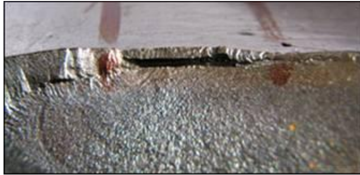
Abbildung 4-42: Bruchfläche im Kopf einer R350HT-Schiene der Wiener U-Bahn, man erkennt die Delamination von Teilen der Fahrfläche und das anschließende Ermüdungsrisswachstum in den Schienenkopf hinein
