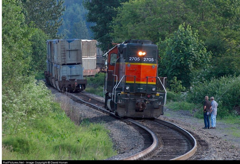
Abbildung D-33: Umgekippte Schiene zufolge unzureichende Schienenbefestigung (RailPictures.net)
