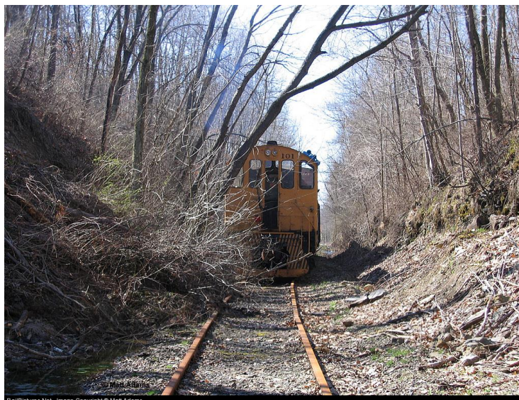
Abbildung D-34: Hangrutschung (RailPictures.net)
