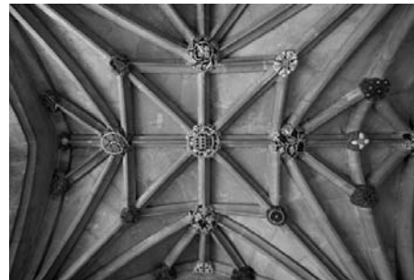
Abbildung 2. 33: Magdalen College: Deckenkonstruktion des Glockenturmes
