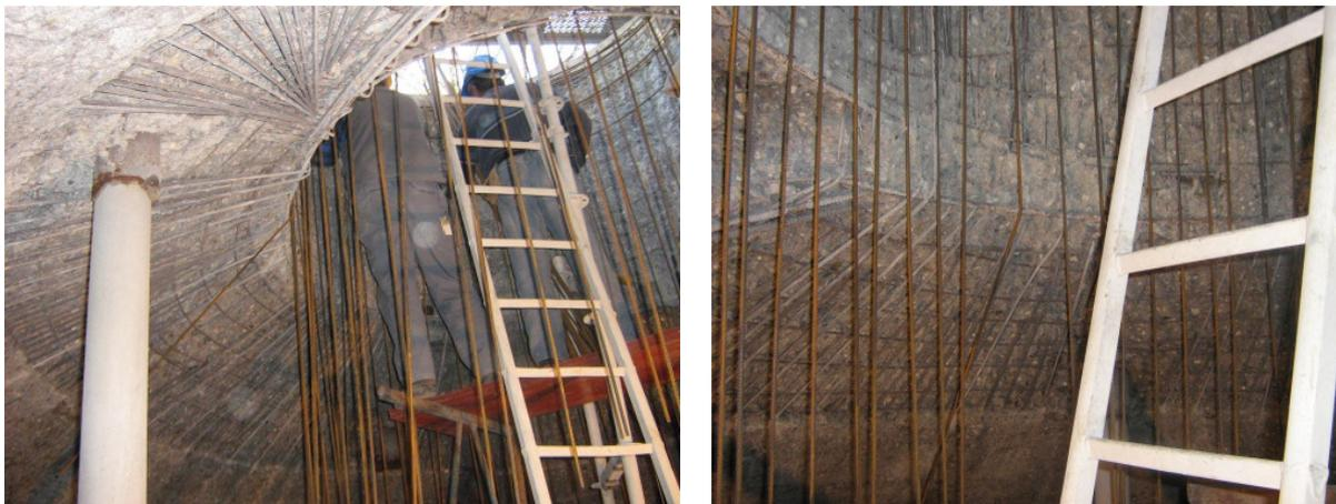
Abbildungen 5 und 6: Freigelegte und gereinigte Bewehrung im Gasraum
