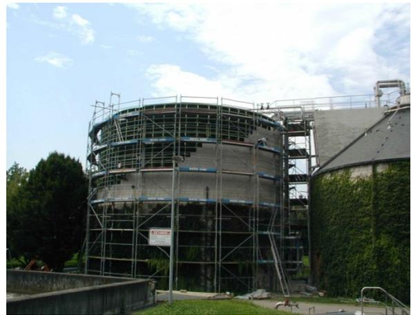
Abbildungen 15 und 16: Ansicht des Abbruchs und Außenansicht mit Arbeitsgerüst
