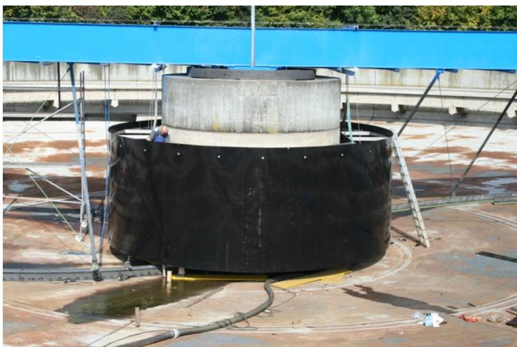
Abbildung 2: Eingebaute Tauchwand vor Befüllung des Nachklärbeckens
