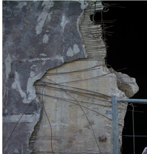
Abbildungen 11 und 12: Abbruch eines Faulbehälters auf der Kläranlage Pforzheim mit in Wickeltechnik vorgespannter, korrodierter Zylinderbewehrung
