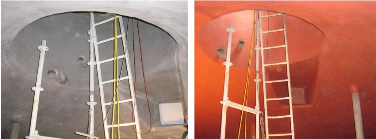
Abbildungen 7 und 8: Applikation einer vollflächigen Reprofilierung mittels SPCC (links) und der BSK-resistenten Beschichtung
