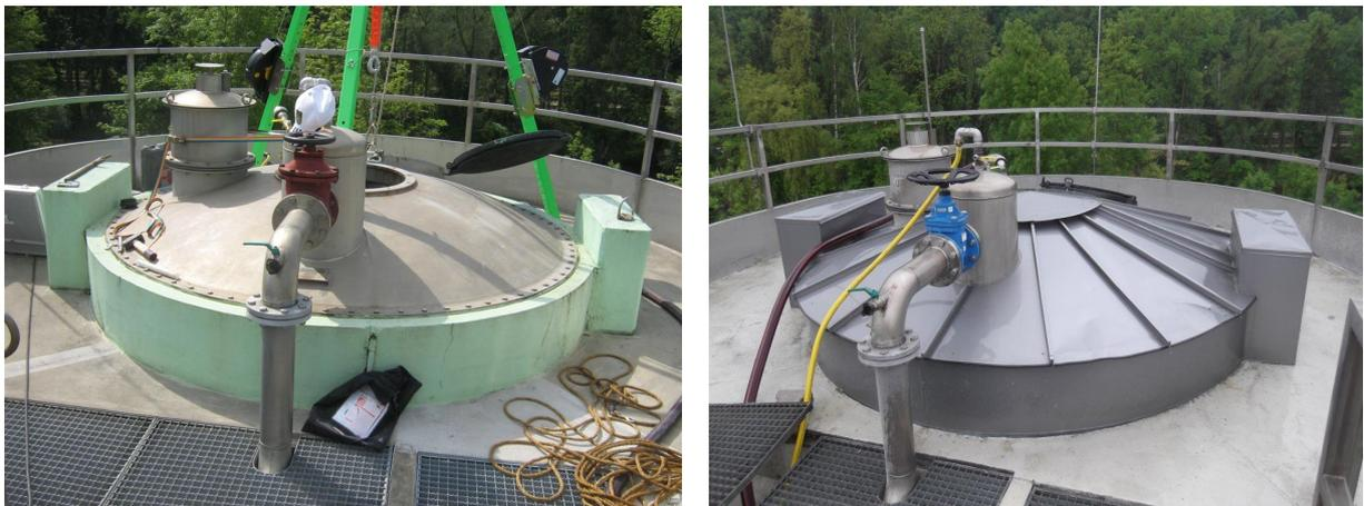
Abbildungen 9 und 10: Faulbehälterkopf am Faulbehälter Günzburg vor der Instandsetzung (links) und rechts nach dem Aufbringen der Wärmedämmung einschließlich der Blechverkleidung
