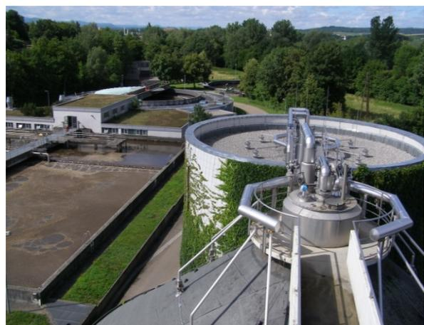
Abbildungen 17 und 18: Betonieren der erhöhten Zylinderwand und Blick auf den fertiggestellten Faulbehälterkopf und den benachbarten Faulbehälter
