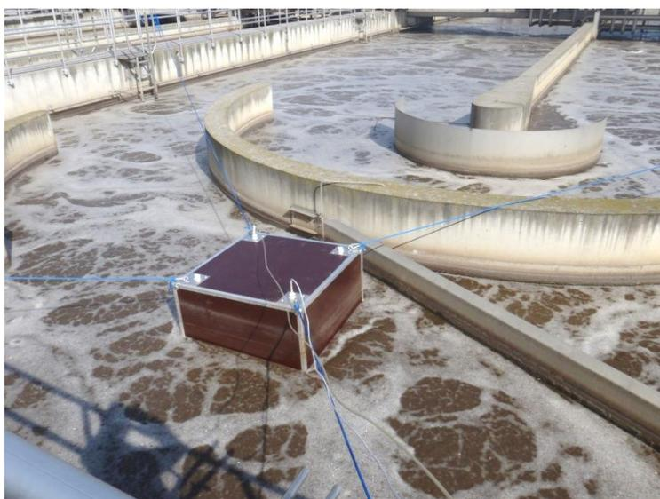
Abbildung 4: Ablufthaube zur Erfassung eines Teilstromes der Abluft aus dem Belebungsbecken
