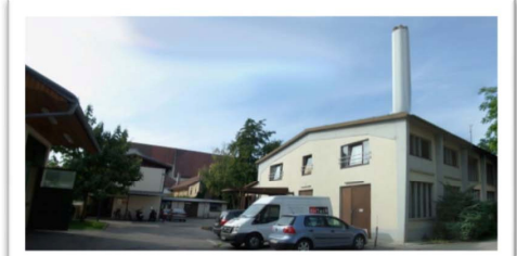
Infrastrukturgebäude (Kesselhaus, Tischlerei, ...) Nach 1945 laufend adaptiert.
