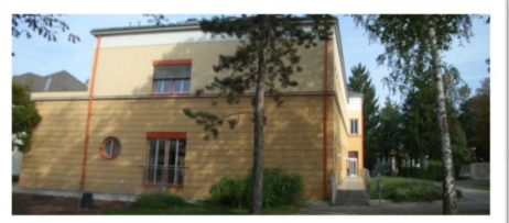
Zubau Kinderabteilung (erbaut 2000)
