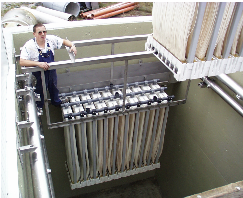
Abbildung 11-49: Hohlfasermembran beim Einbau, Quelle: SANDOZ Ges.m.b.H.
