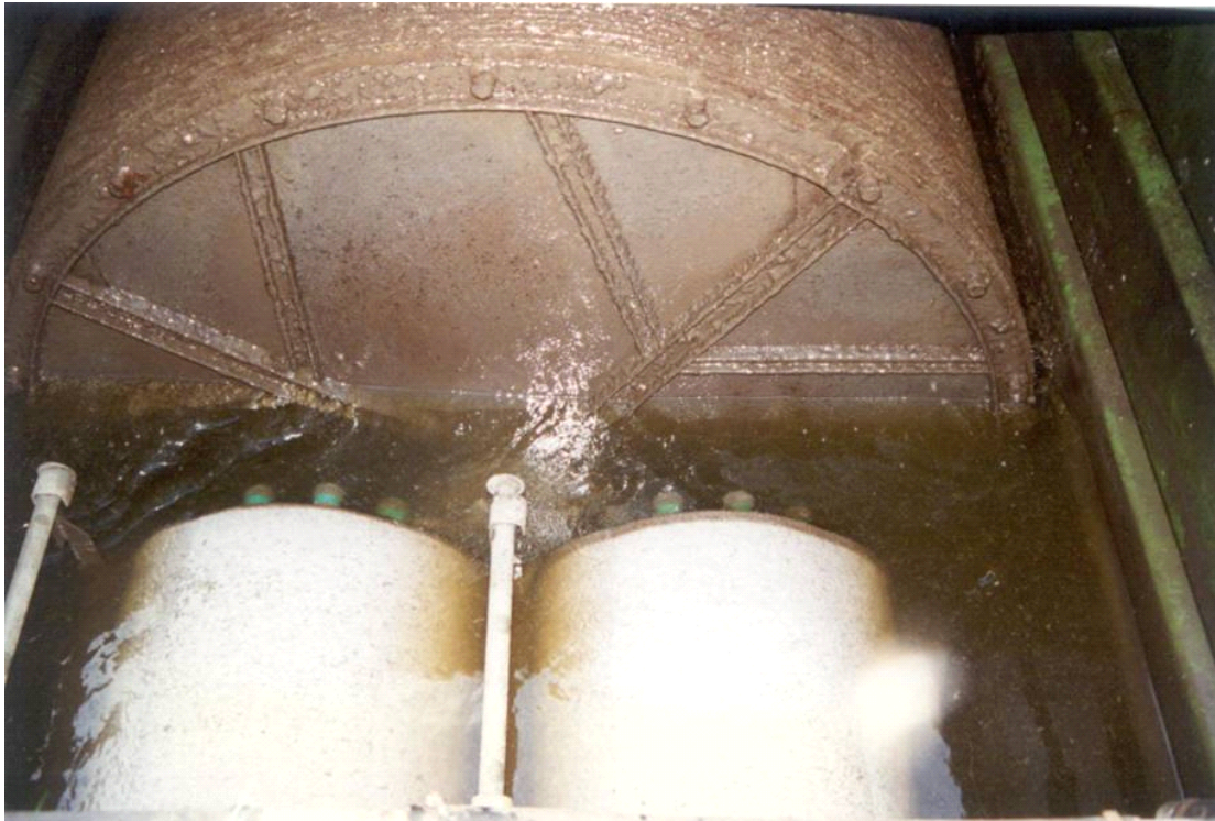
Abbildung 10-7: Scheibentauchkörper mit Tuchfilter.
