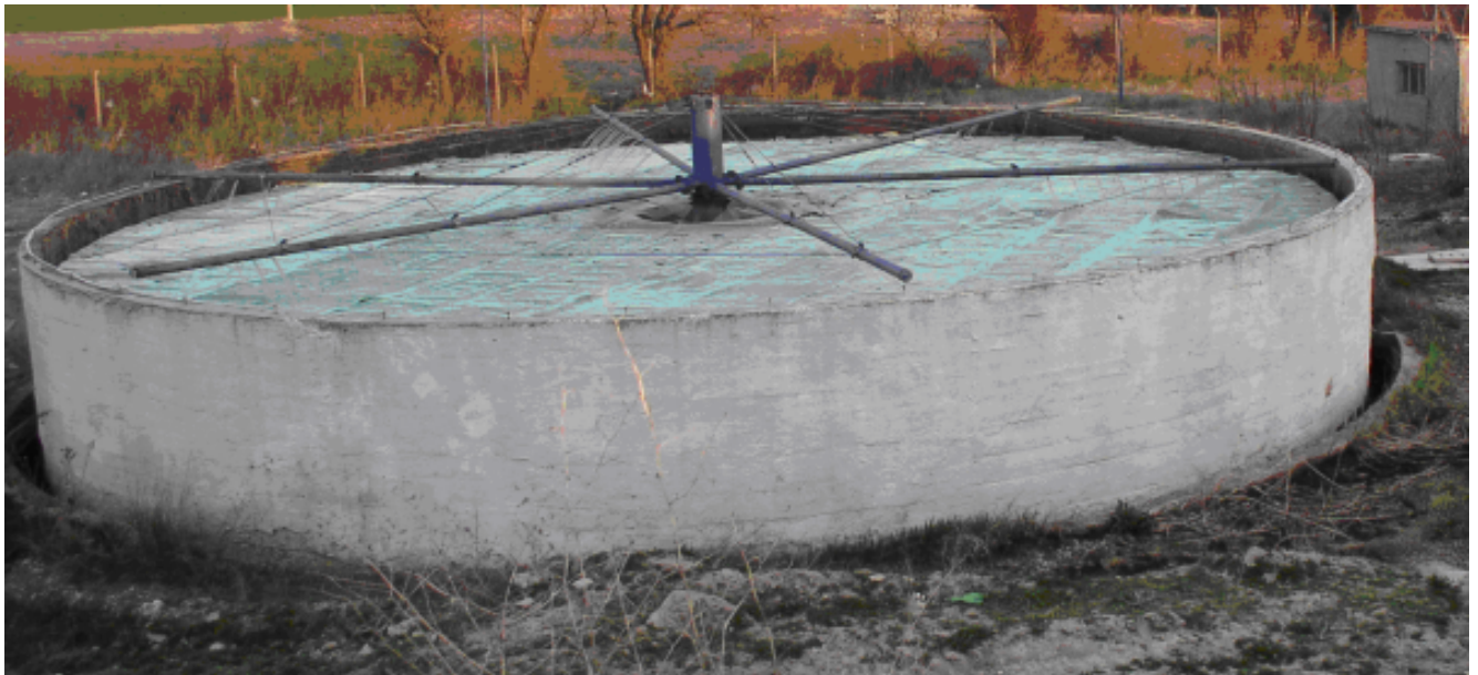
Abbildung 10-3: Tropfkörper mit Drehsprenger.
