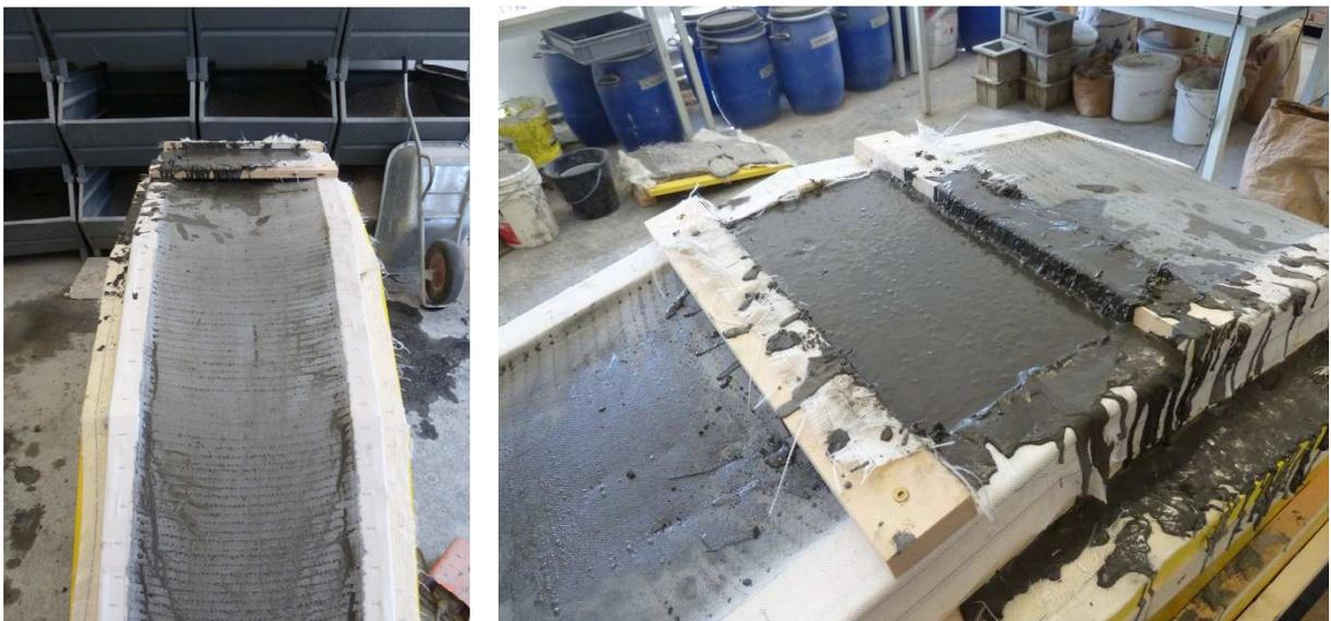
Abbildung 5-9: Vollständig ausbetoniertes Schalungssystem
