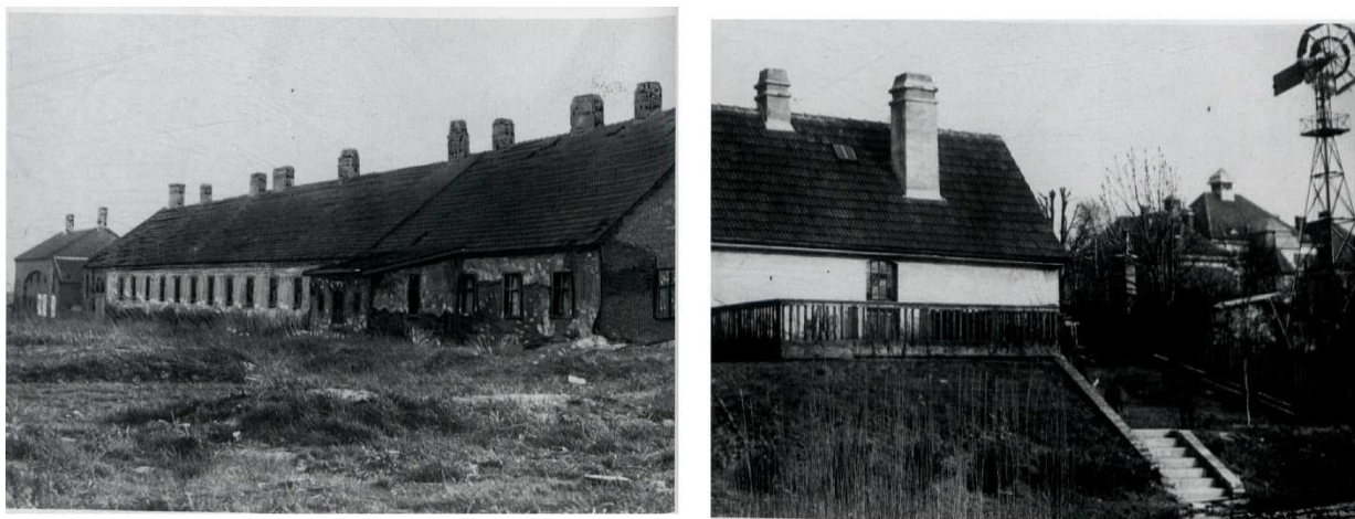
Abbildung 9: links: Ziegeleiarbeiterwohnhaus 1927, rechts: Hasenstall des Ziegeleidirektors 1927 19
