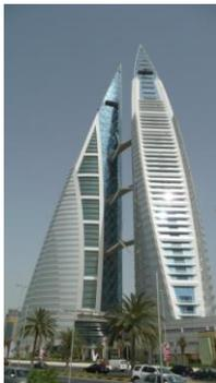
Das World Trade Center im Bahrain in wurde so konzipiert dass die Form der Türme die Luft zu den zwischen den beiden Türmen befindlichen Rotoren stets im gleichen Luftanströmungswinkel lenkt. Die Rotoren nutzen die Windenergie um Elektrizität zu erzeugen.
