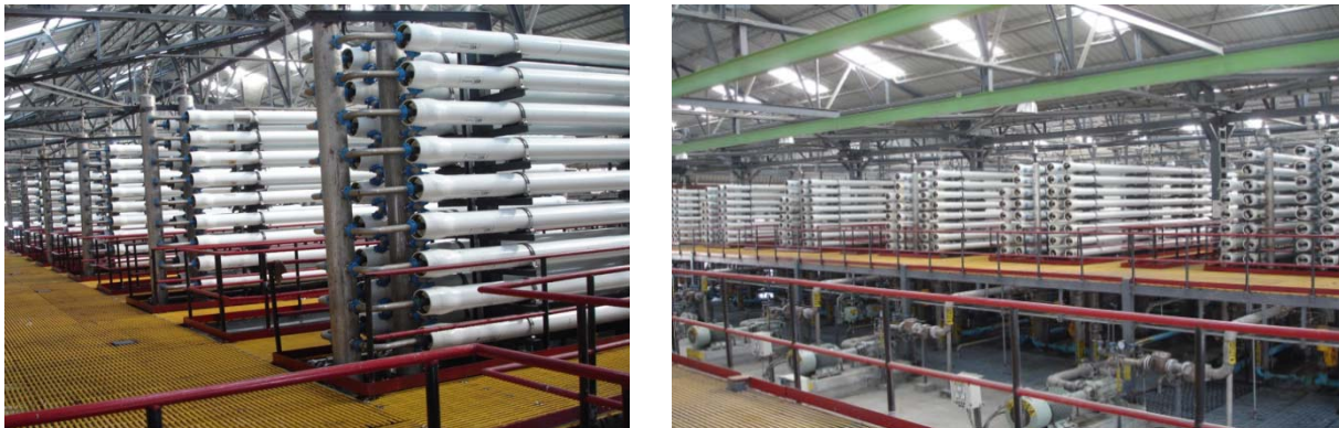
Abbildung 6: PR-WRP - Ultra-Filtration (links) und Umkehrosmose I (rechts)
