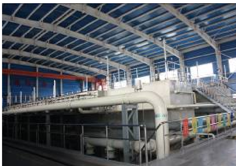
Abbildung 1: QH-WRP 1 – Tertiäre Ultra-Filtration (ZeeWeed 1000)
