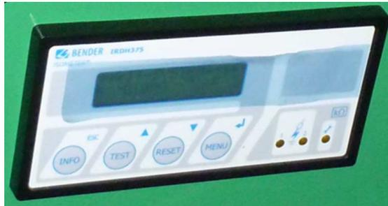
**Abb. 9.11:** Anzeige des im ZWG eingebauten Isolationswächters
