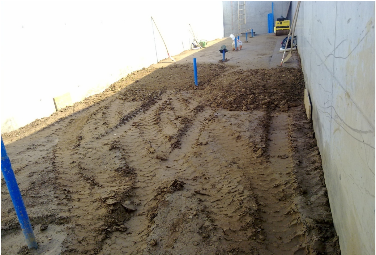
Abbildung 3.13 Lagenweises Einbringen des bindigen Deckschichtmaterials
