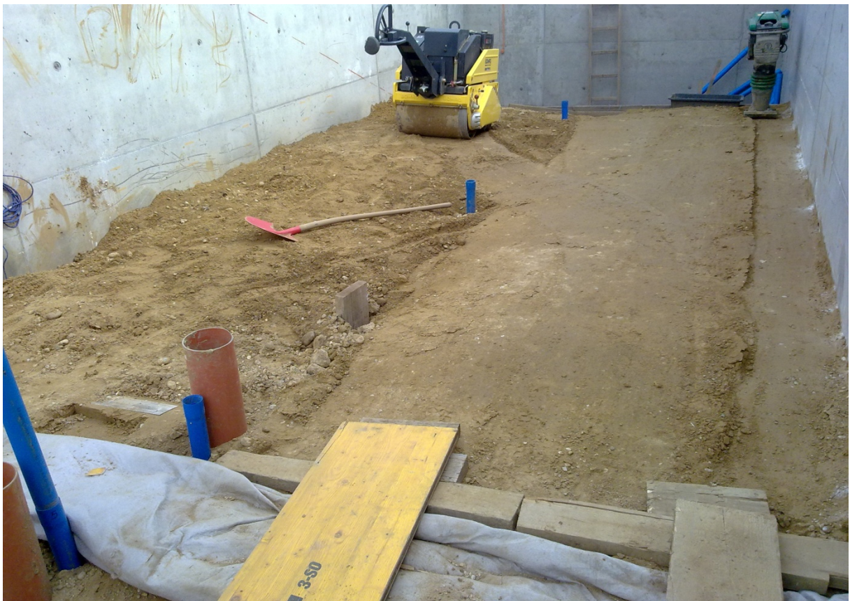
Abbildung 3.16 Verdichtung der Dammschüttlagen mittels Vibrationswalze und Stampfer, zusätzliches Einbringen von Bentonitpulver zur Verhinderung von Fugenerosion an den Stahlbetonwänden
