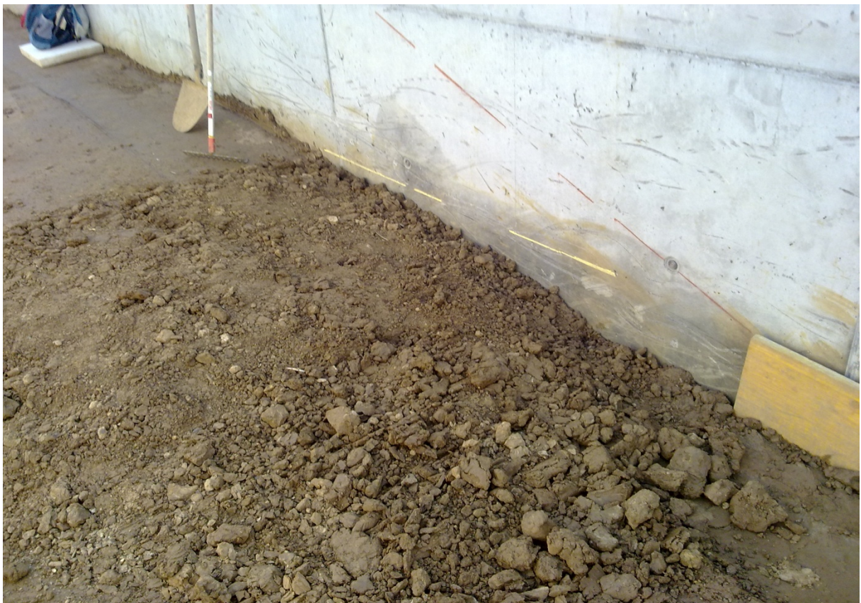
Abbildung 3.14 Deckschichtmaterial vor und nach der Verdichtung
