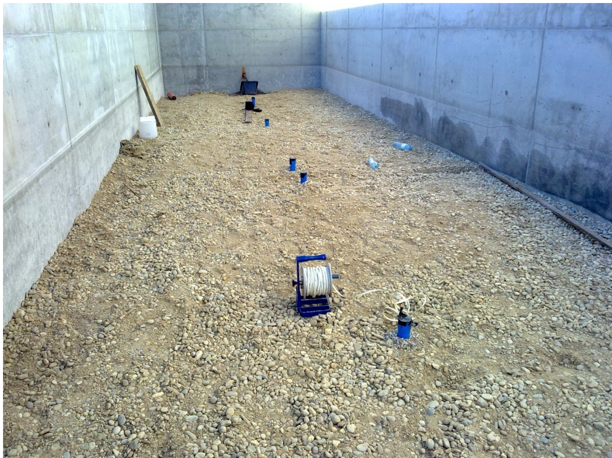
Abbildung 3.12 Vorversuch zur Überprüfung der Durchlässigkeit nach Fertigstellung des Grundwasserleiters, Ermittlung des Wasserstandes im Standrohr mittels elektrischen Spitzenpegel und Maßband, Zufluss über Auslässe in der Rückwand des Stahlbetontroges;
