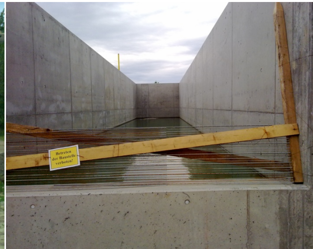
Abbildung 3.3 Blick in den wassergefüllten Stahlbetontrog
