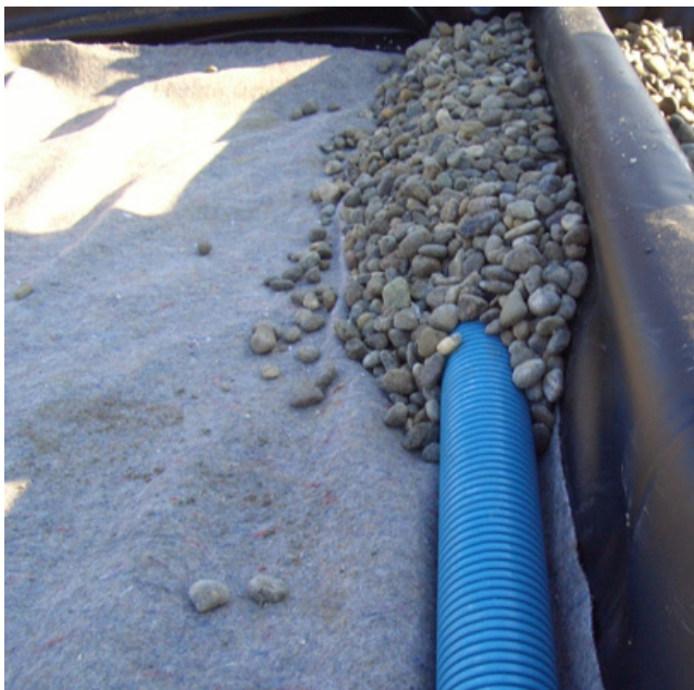
Abbildung 2.10 (oben): Drainagerohr in Kiesbett auf Filtervlies.
