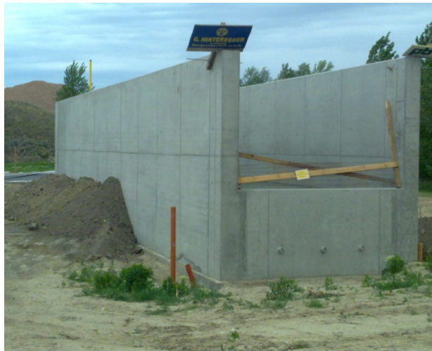
Abbildung 3.2 Stahlbetontrog des Feldversuches
