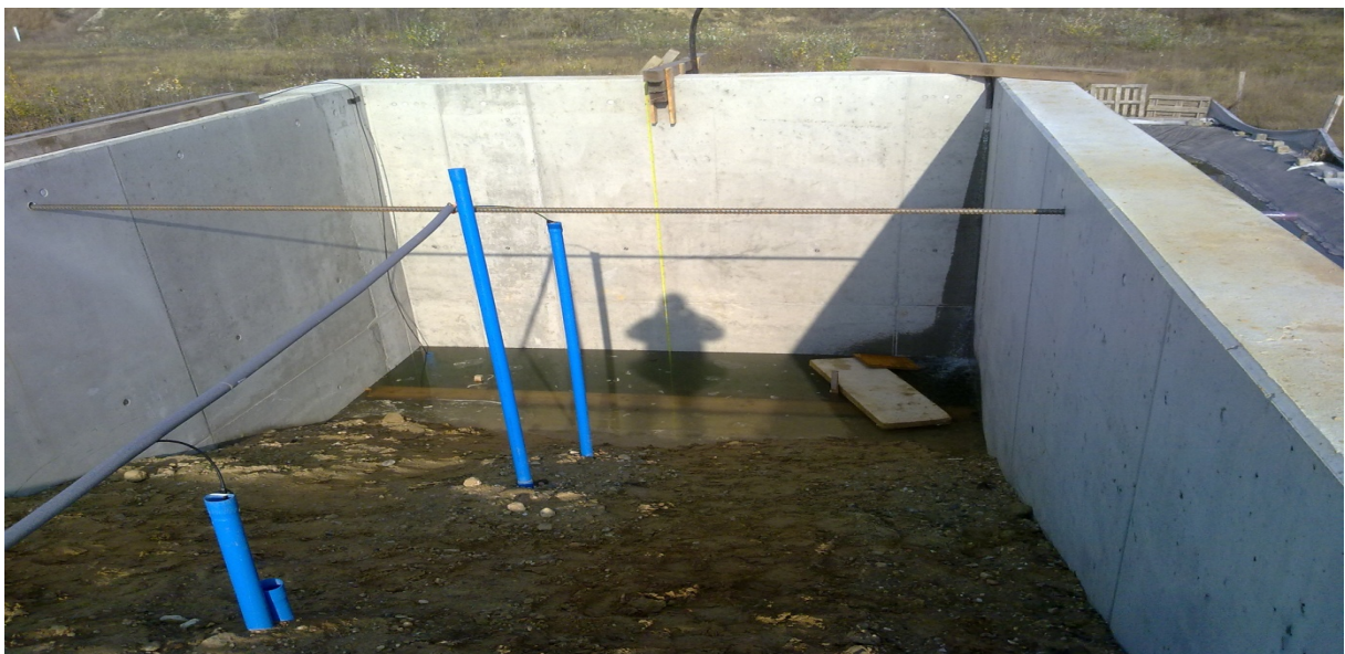
Abbildung 3.34 Blick von der Dammkrone in das Versuchsbecken: simulierter Hochwasserstand auf Niveau der Deckschichtoberkante bzw. Geländeoberkante, rechts im Bild: Zufluss und Wasserspiegelberuhigung
