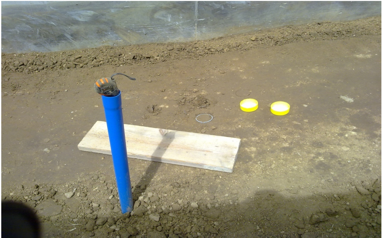
Abbildung 3.15 Probenentnahmen aus einer verdichteten Schüttlage zur Bestimmung der Bodenkennwerte
