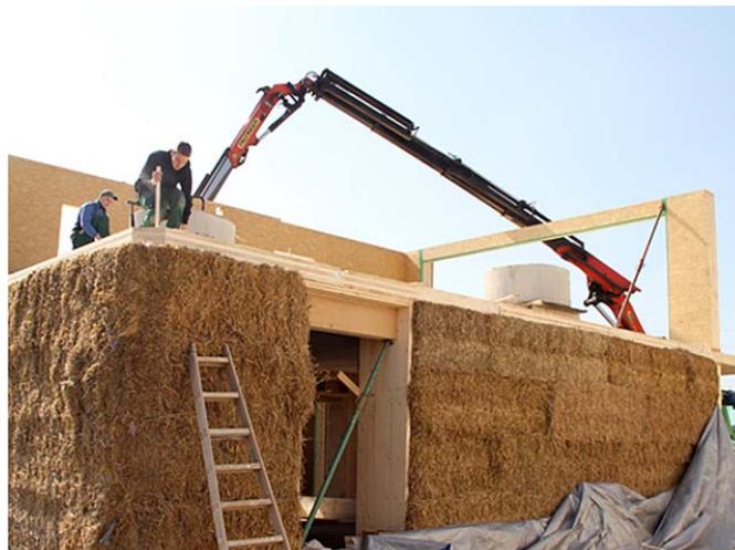
Abb. 4-58: „Strohballenbau – Musterhaus: Zwischendeckenmontage“
