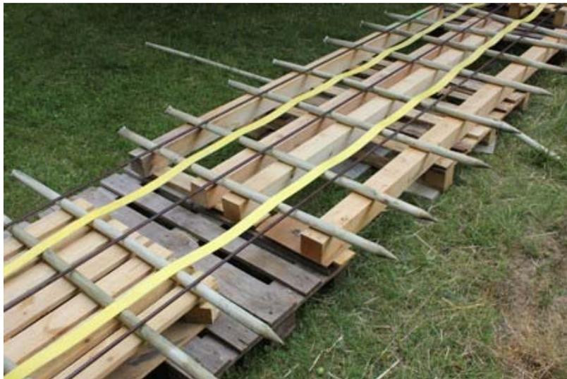
Abb. 6-3: „Unterbau für die Herstellung des horizontalen Strohballentragwerks“
