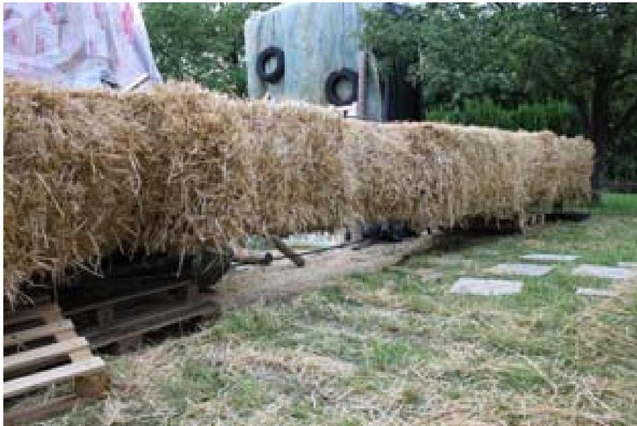
Abb. 6-5: „Deckenträger auf Holzpaletten im lichten Abstand von 350 cm auf Holzpaletten gelegt“ (Foto des Verfassers)
