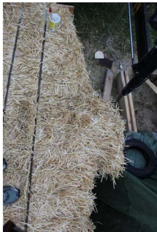
Abb. 6-4: „Aufschiebungen im Bereich der Ballenstöße“
