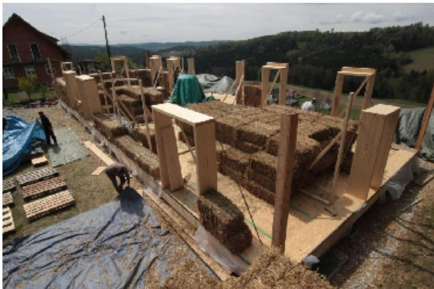
Abb. 4-50: „Haus Keimel Lessing – während der Errichtung“ (Aus der Homepage von „ASBN – Austrian Straw Bale Network (Österreichisches Netzwerk für Strohballenbau)“: [http://www.baubiologie.at/\\_system/bilder/370/projekt\\_Erstes\\_baugenehmigtes\\_lasttragendes\\_Strohballenhaus\\_3521.jpg](http://www.baubiologie.at/_system/bilder/370/projekt_Erstes_baugenehmigtes_lasttragendes_Strohballenhaus_3521.jpg); abgerufen am 30. 08. 2014)
