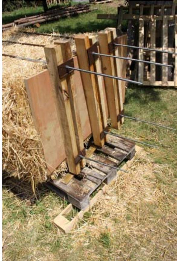
Abb. 6-1: „Vorspannvorrichtung für das horizontale Strohballen-Tragwerk“
