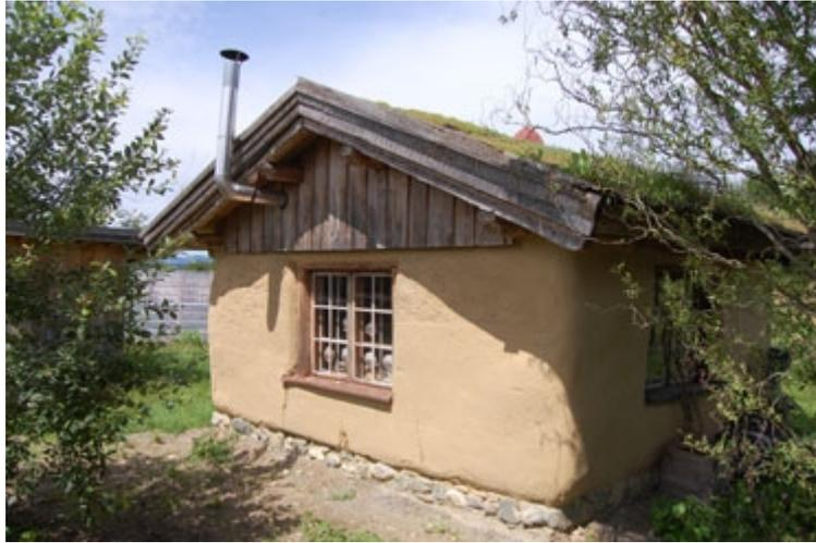
Abb. 4- 49: „Erstes lasttragendes Strohhaus in Österreich als Nebengebäude“ (Aus der Homepage von „ASBN – Austrian Straw Bale Network (Österreichisches Netzwerk für Strohballenbau)“: [http://www.baubiologie.at/\\_system/bilder/166/projekt\\_Lasttragendes\\_Strohballenhaus\\_in\\_St\\_Georgen\\_Kaernten\\_909.jpg](http://www.baubiologie.at/_system/bilder/166/projekt_Lasttragendes_Strohballenhaus_in_St_Georgen_Kaernten_909.jpg), abgerufen am 30. 08. 2014)
