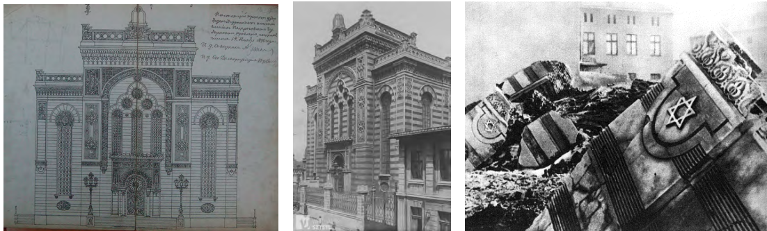
Abb. 35-37: Frontansicht mit Einkerbungen; Aufnahme Synagoge mit Einkerbungen; Aufnahme der zerstörten Synagoge (Detailaufnahme der Einkerbungen in der Außenwand)
