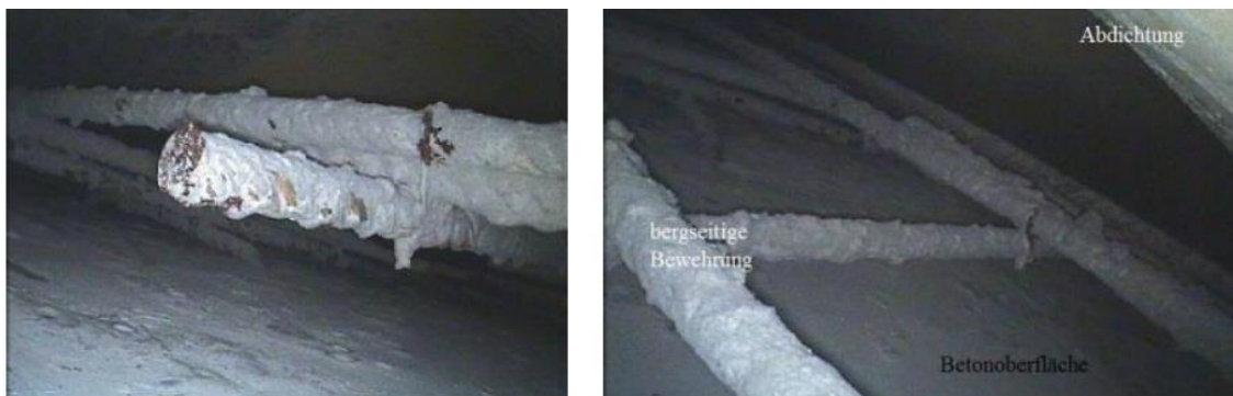
Abb. 5.14: Spaltbildung im Firstbereich 131
