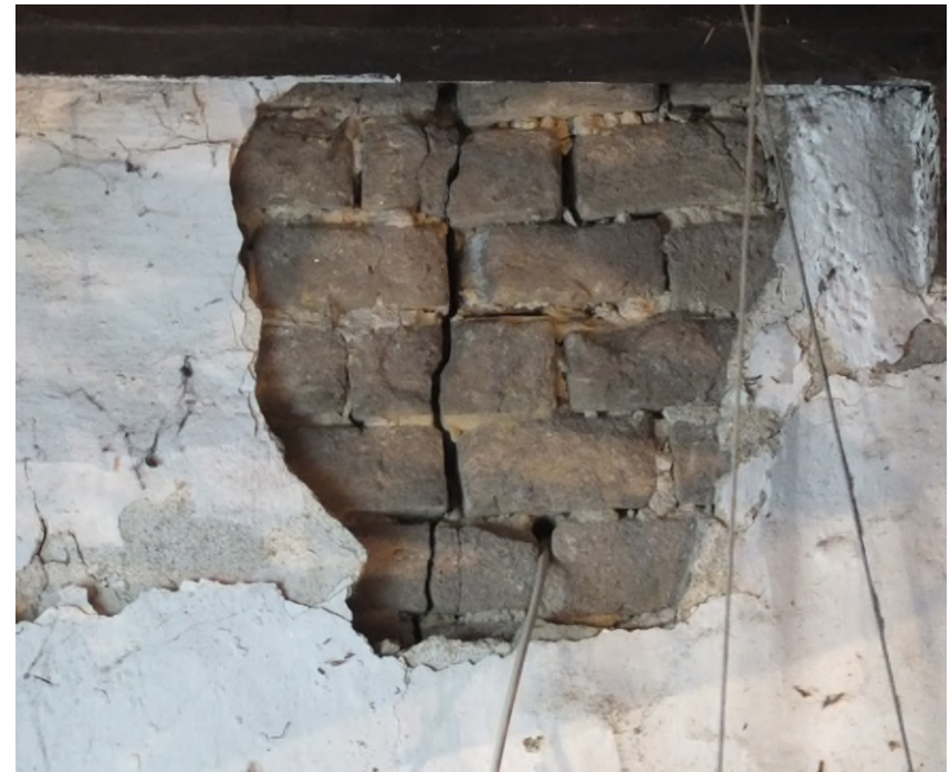
Lehmwand Presshaus – innen
