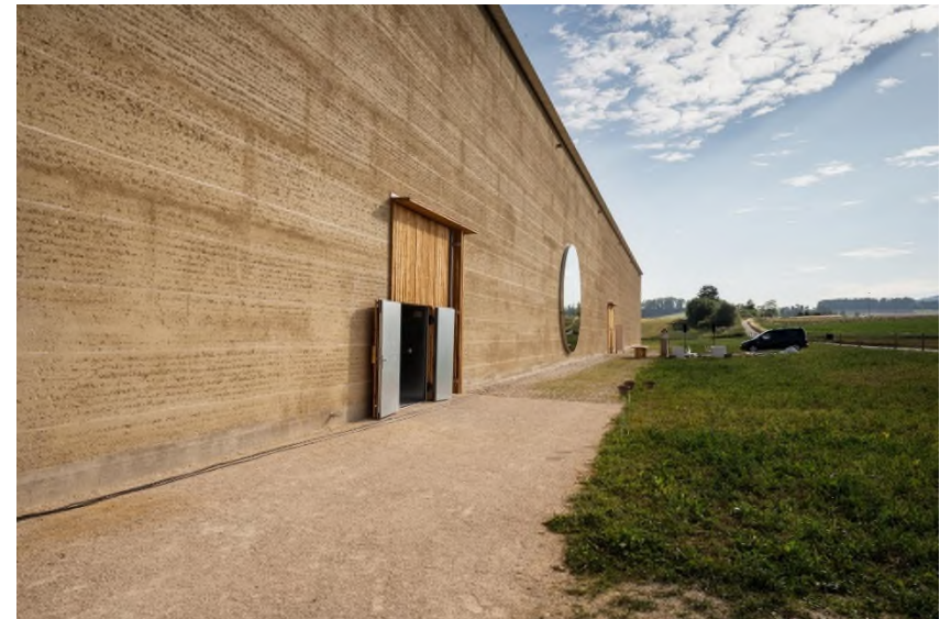
Lehmhaufassade der Ricola Fabrik.
