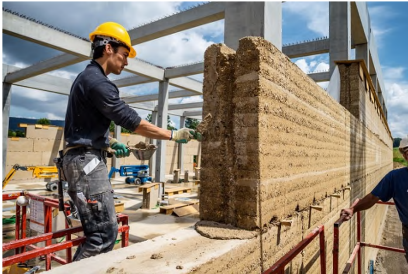
Montage der einzelnen Stampflehm Elemente
