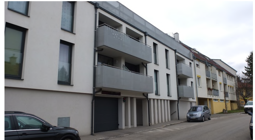
Wohnhausanlagen in der Klostergasse
