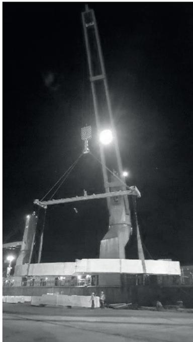
Umgeschlagen in ein Seeschiff erreichten die in zwei Lagen Spezialfolie seefest verpackten Träger und Bauteile weitere acht Wochen später den Hafen von Cebu City. Löschung und Weitertransport zur nur etwa 10 km entfernten Baustelle per Lkw nahmen ca. drei Tage in Anspruch.
