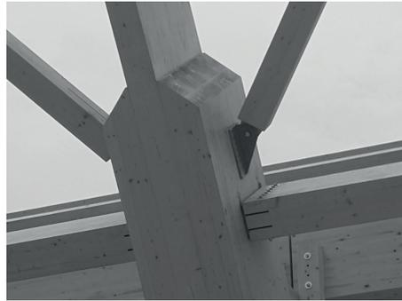
Abb. 19: Mactan Cebu Airport, Sekundärträger und Diagonalanschluss, Foto: RUBNER Holzbau
