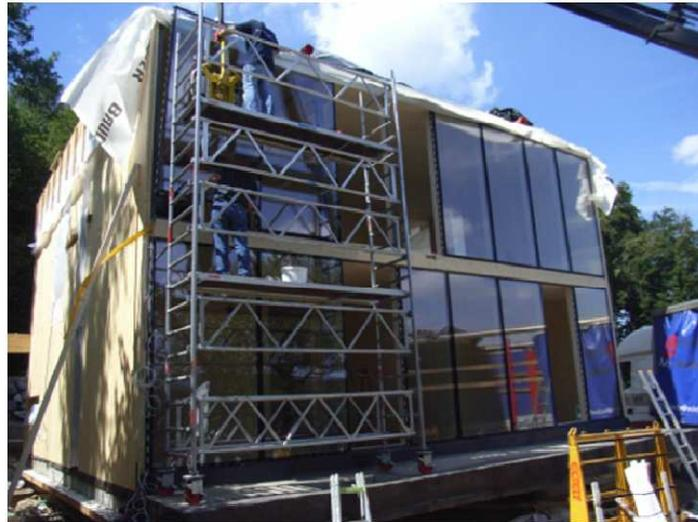
Abbildung 44: Einsetzen der HGV-Elemente auf der Baustelle eines Einfamilienhauses in Eichgraben in Niederösterreich (Neubauer, 2011)
