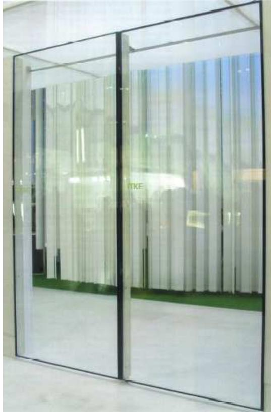
Abbildung 27: GFK-Glas-Fassade auf der glasstec 2004 in Düsseldorf: Prototyp Fassade: Glasmuseum Ebeltoft (Peters, 2006)
