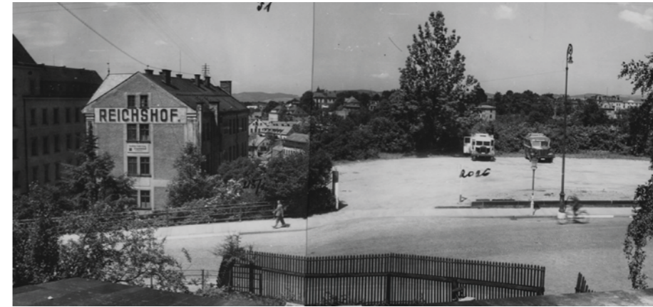
Abb. 60 oben: Synagogengrundstück als Parkplatz; Abb. 61 rechts: Blick zum leeren Synagogengrundstück
